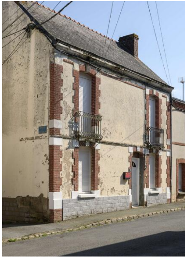
Beausse, 18 rue de la Mairie. Maison, 1er quart 20e siècle. Phot. Armelle Maugin IVR52_20244900458NUCA
