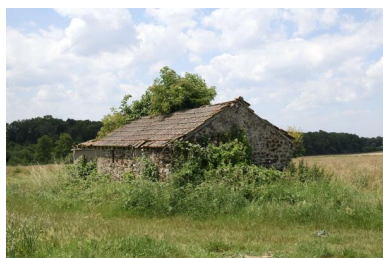
La Lançonnière. Ferme, 3e quart 19e siècle. Phot. Armelle Maugin IVR52_20244900484NUCA
