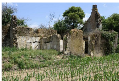
La Lançonnière. Ferme, 3e quart 19e siècle. Phot. Armelle Maugin IVR52_20244900485NUCA
