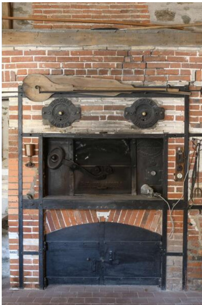
Beausse, 4 rue des Mauges. Ancienne boulangerie, actuellement maison, détail du four à pain.
