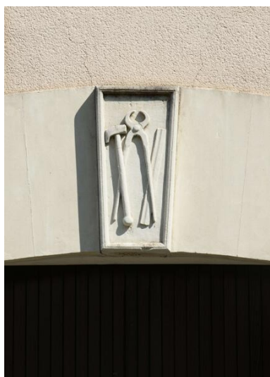
Beausse, 12 rue de la Mairie. Maison et forge, 1905, détail de la clé ornée d'outils de forgeron. Phot. Armelle Maugin IVR52_20244900469NUCA
