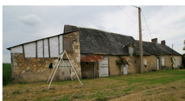
Ancienne et nouvelle maison d'habitation. Phot. Jean-Baptiste Darrasse IVR52_20087200624NUCA
