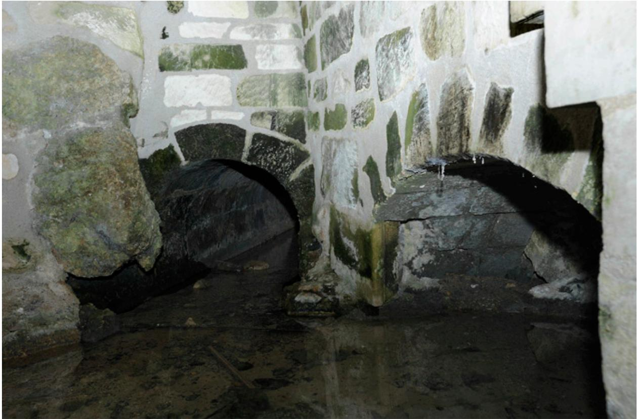
Arcs des canalisations d'écoulement des eaux
