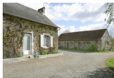
Le logis et le fournil-porcherie. Phot. François Lasa IVR52_20035301395NUCA
