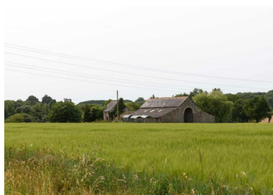
Vue d'ensemble de la ferme depuis l'est. Phot. Armelle Maugin IVR52_20254900678NUCA
