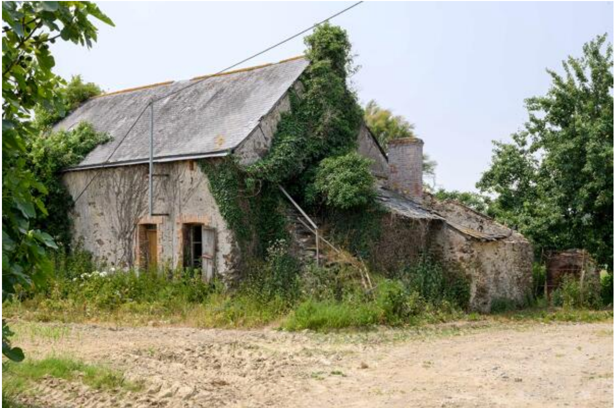
Vue du logis depuis l'est.
