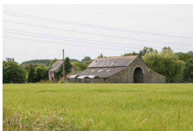
Vue d'ensemble de la ferme depuis l'est. Phot. Armelle Maugin IVR52_20254900679NUCA
