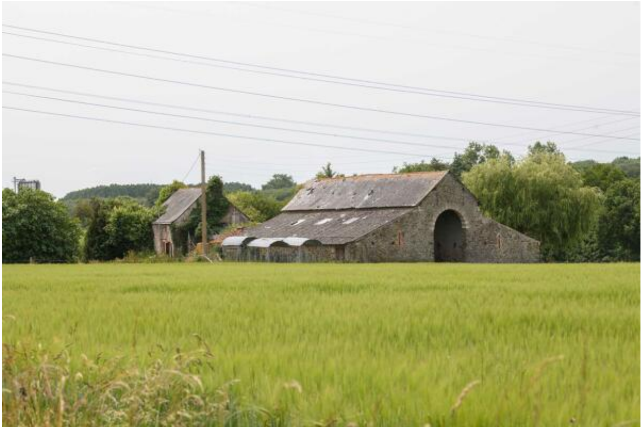
Vue d'ensemble de la ferme depuis l'est.
