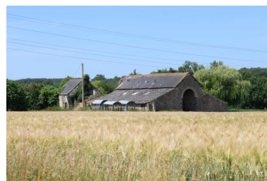
Vue de la ferme depuis l'est. Phot. Armelle Maugin IVR52_20254900911NUCA
