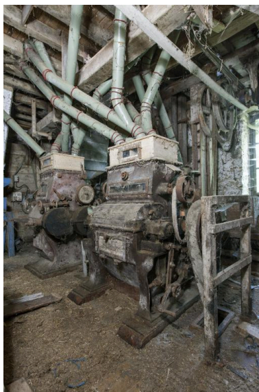
Broyeurs à cylindres du moulin du Hazay. Phot. Yves Guillotin IVR52_20185300412NUCA
