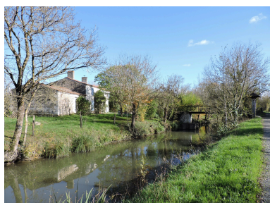
Le canal de Bourneau à la Hausse, en amont du port de Maillé. Phot. Yannis Suire IVR52_20218500515NUCA
