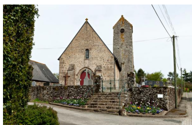
Façade occidentale de l'église Saint-Fraimbault. Phot. Yves Guillotin IVR52_20195300513NUCA
