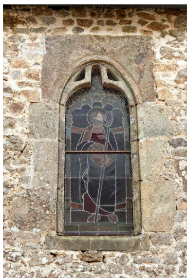
Baie occidentale du mur-gouttereau nord de la nef. Phot. Yves Guillotin IVR52_20195300505NUCA
