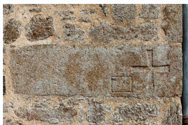
Pierre tombale réemployée dans la chaîne d'angle sud du massif occidental de l'église Saint-Fraimbault Phot. Yves Guillotin IVR52_20195300502NUCA
