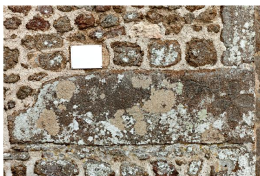
Chaîne d'angle nord-ouest, face nord, remploi de pierres tombales. Phot. Yves Guillotin IVR52_20195300507NUCA
