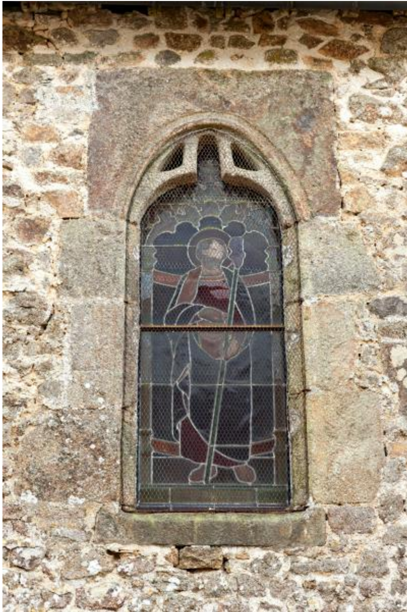
Baie occidentale du mur-gouttereau nord de la nef.
