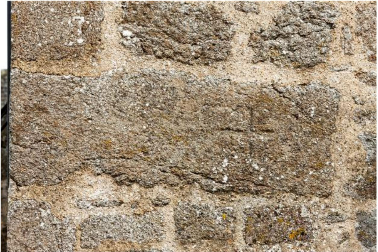
Chaîne d'angle nord-ouest de la nef de l'église Saint-Fraimbault de Saint-Fraimbault de Lassay, face occidentale, pierre tombale en remploi.
