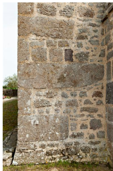
Chaîne d'angle nord-ouest de la nef de l'église Saint-Fraimbault de Saint-Fraimbault de Lassay, remploi de pierres tombales Phot. Yves Guillotin IVR52_20195300504NUCA
