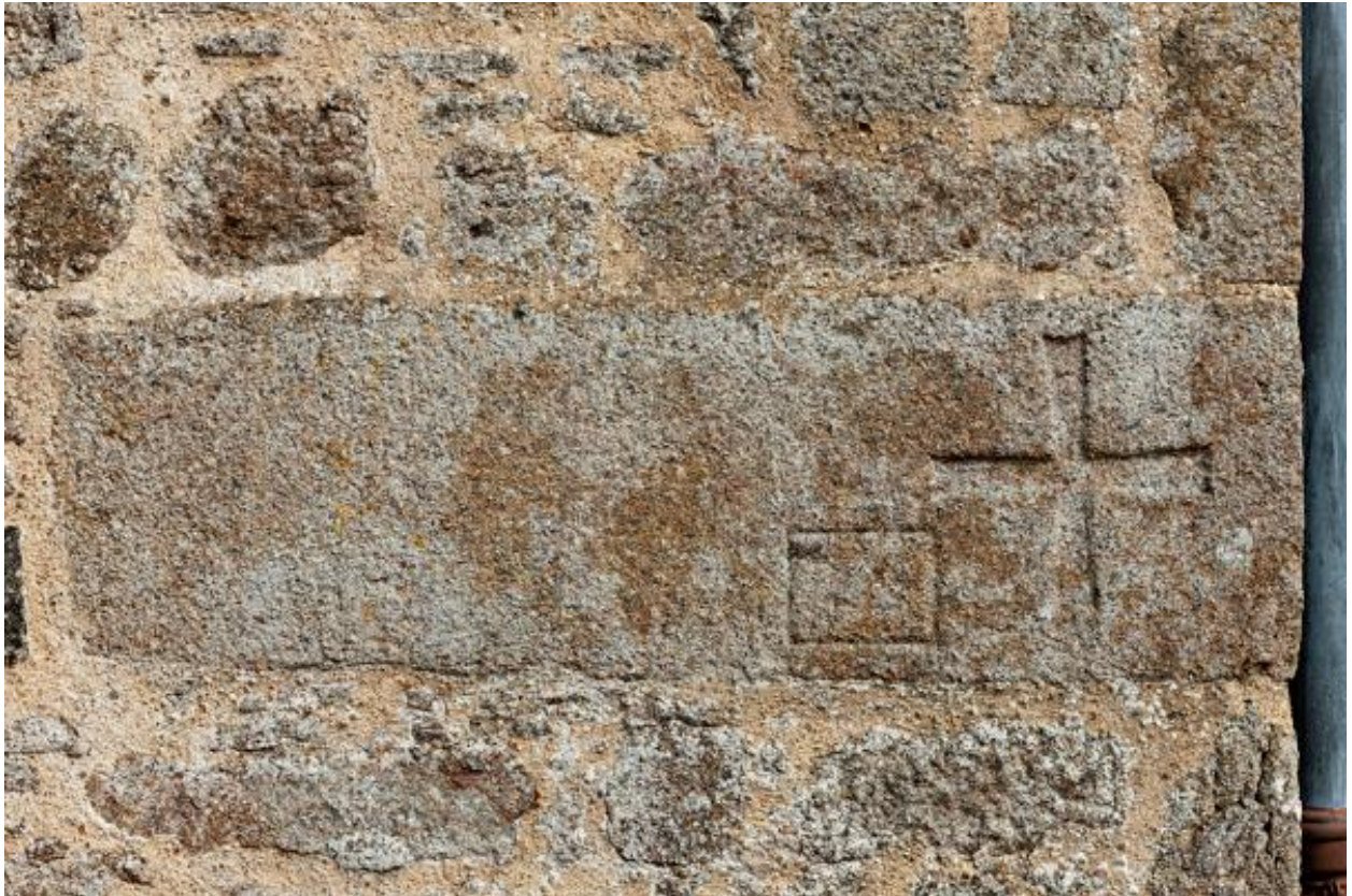
Pierre tombale réemployée dans la chaîne d'angle sud du massif occidental de l'église Saint-Fraimbault
