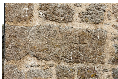
Chaîne d'angle nord-ouest de la nef de l'église Saint-Fraimbault de Saint-Fraimbault
