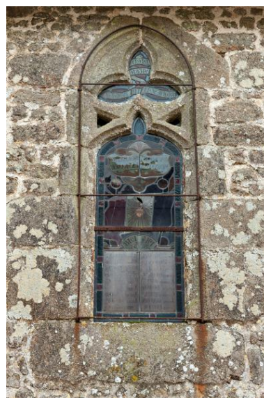
Baie orientale du mur-gouttereau nord de la nef. Phot. Yves Guillotin IVR52_20195300506NUCA
