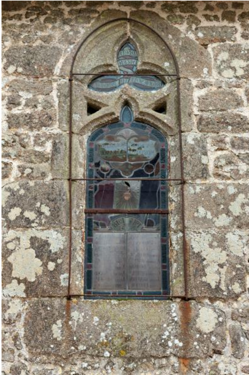
Baie orientale du mur-gouttereau nord de la nef.
