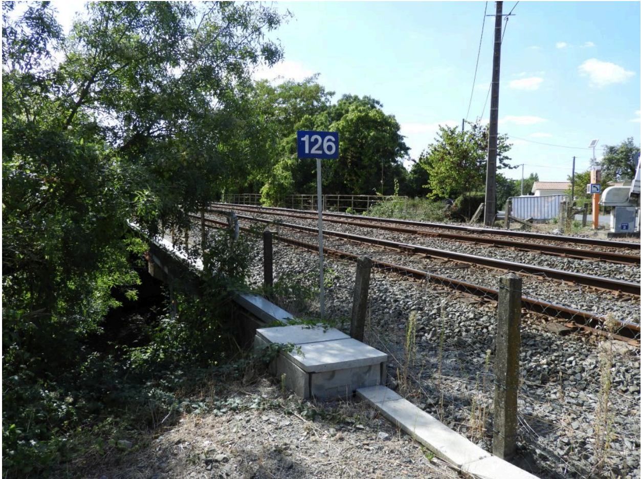
Le pont sur le canal de Vix vu depuis le nord-est.
