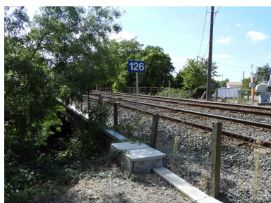
Le pont sur le canal de Vix vu depuis le nord-est. Phot. Yannis Suire IVR52_20198500157NUCA
