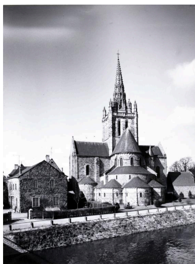
Eglise, vue d'ensemble depuis le sud-ouest. Phot. François Lasa IVR52_19845300227V
