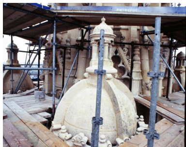
Basilique, clocher : détail du lanternon nord-ouest, face nord-ouest.
