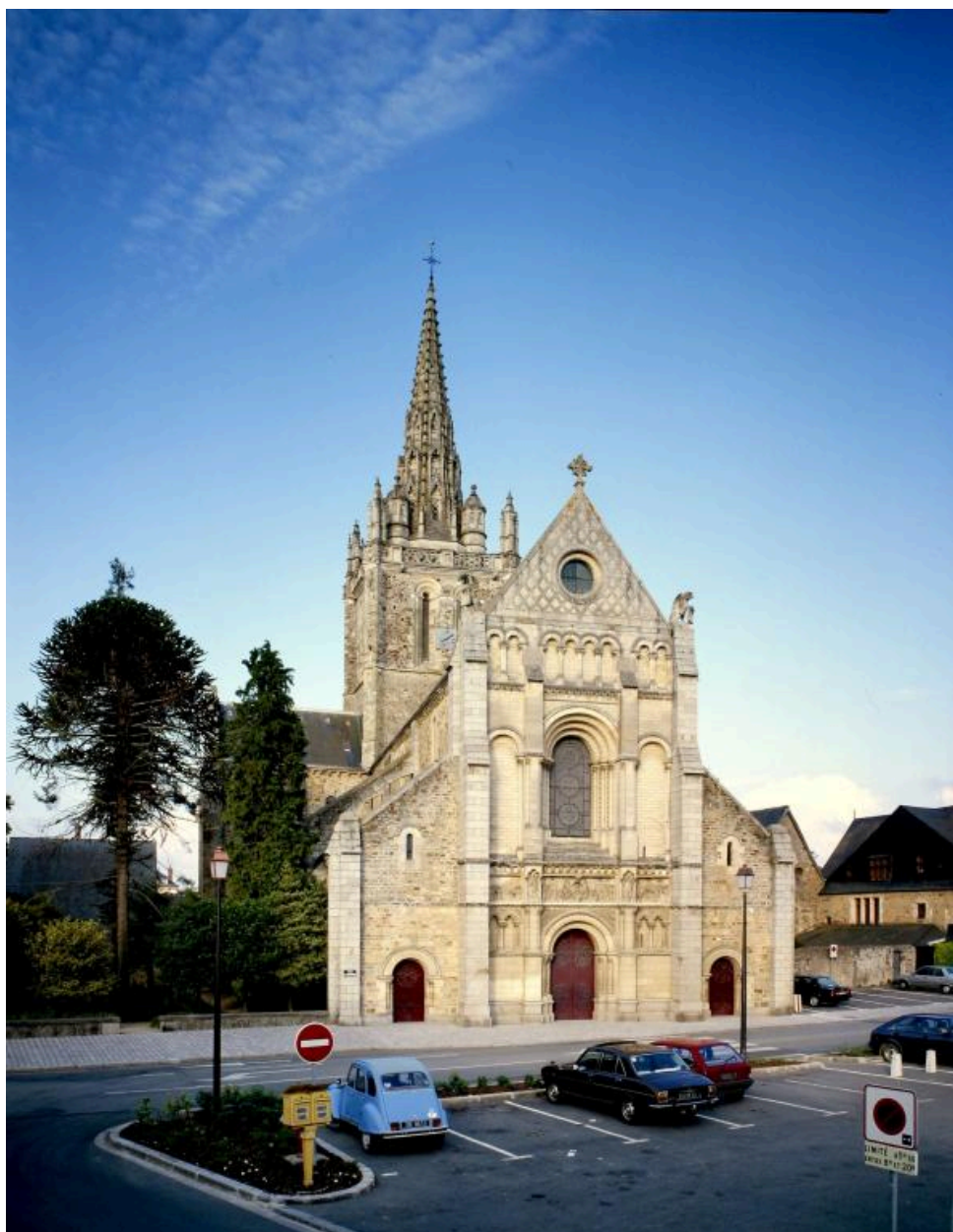
Vue d'ensemble depuis la place d'Avesnières.
