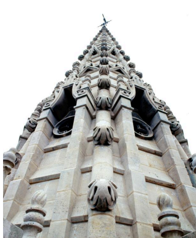
Basilique, clocher : détail de la flèche
