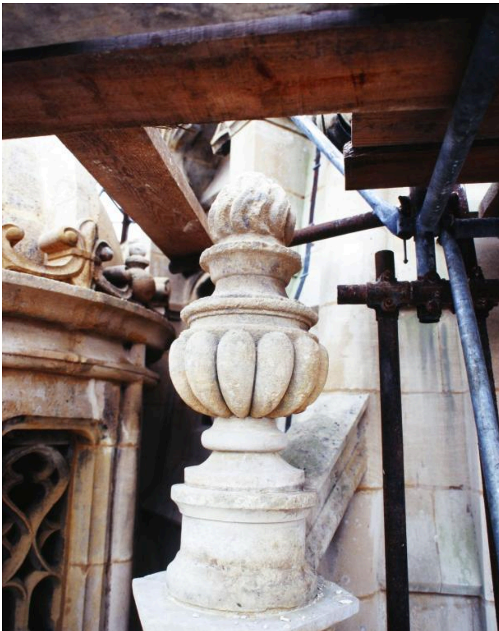
Basilique, clocher : détail ornemental, pot à feu.
