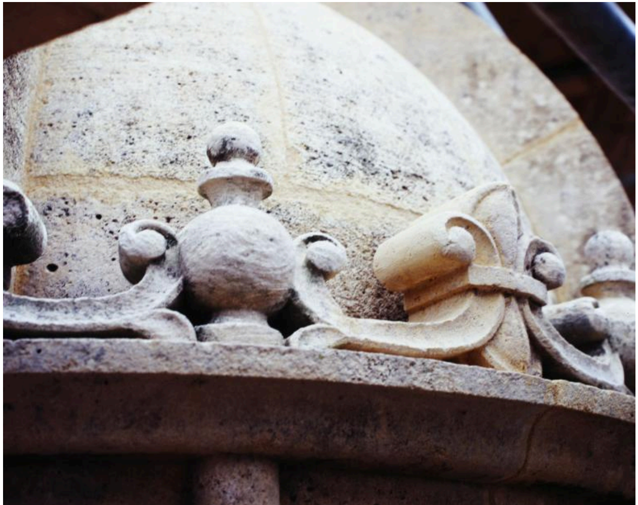
Basilique, clocher : détail de l'ornementation d'un lanterneau.
