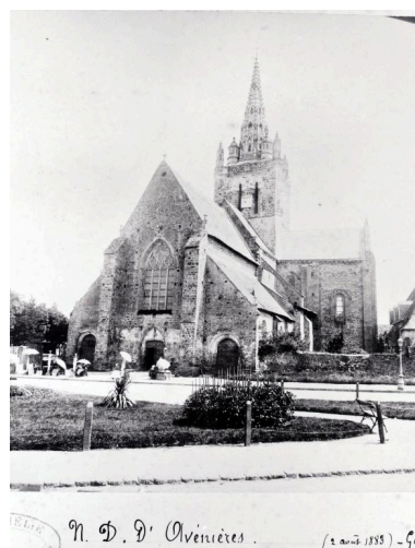
Vue d'ensemble depuis l'ouest avant la reconstruction de la nef. Phot. François Lasa IVR52_19985300184X
