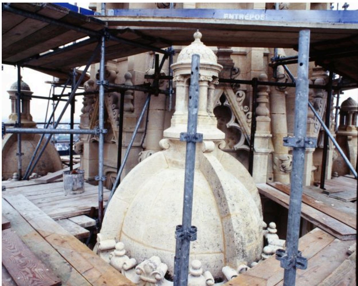
Basilique, clocher : détail du lanternon nord-ouest, face nord-ouest.
