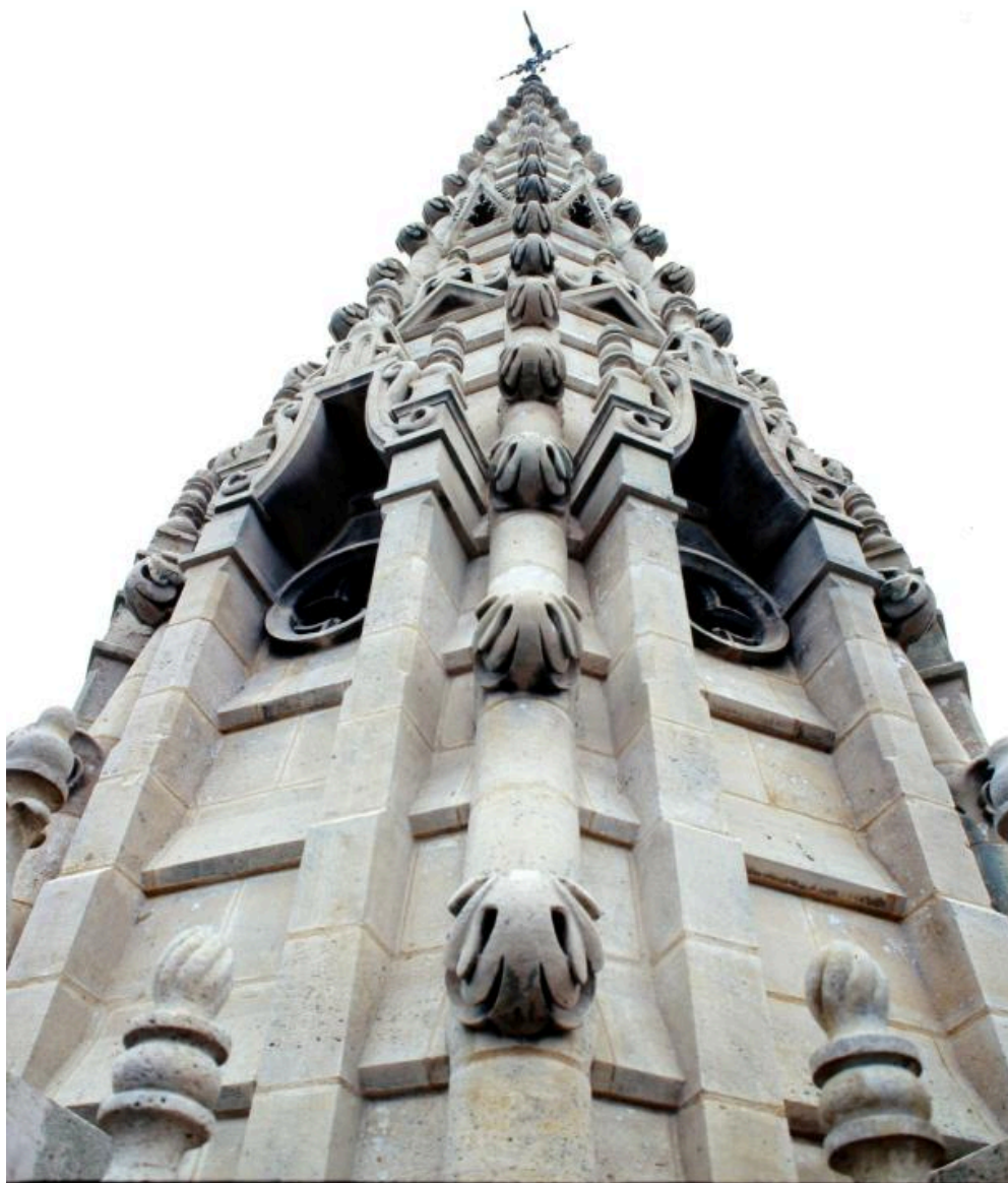
Basilique, clocher : détail de la flèche
