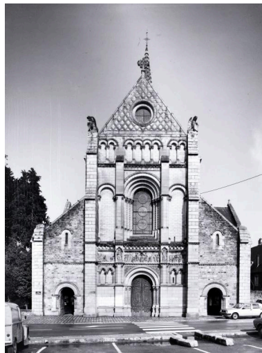
Elévation antérieure. Phot. François Lasa IVR52_19845300226V
