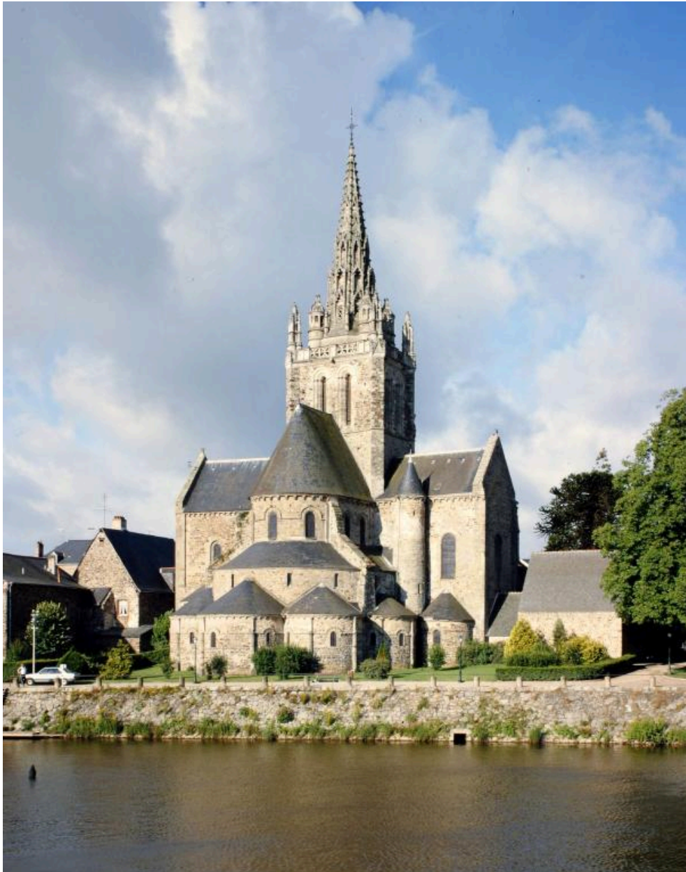
Vue d'ensemble du chevet depuis le nord-est.
