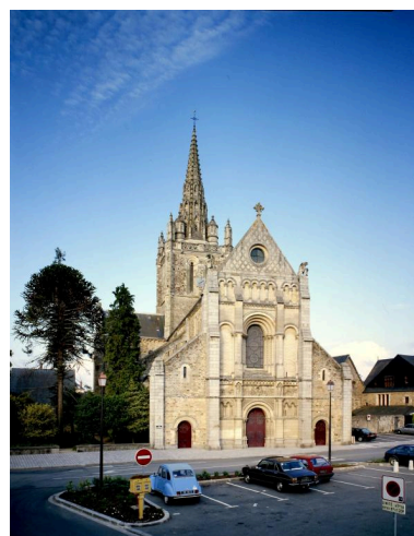
Vue d'ensemble depuis la place d'Avesnières. Phot. François Lasa IVR52_19885300415VA
