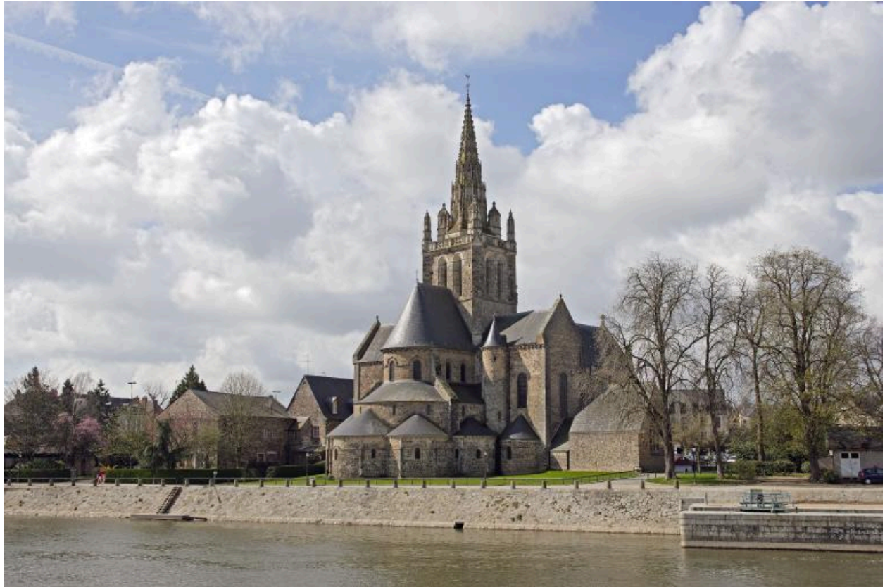
Chevet. Vue d'ensemble depuis le nord-est.
