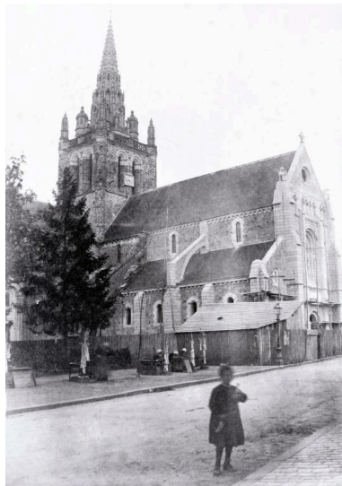
Vue d'ensemble depuis le nord-ouest au moment de l'achèvement de la reconstruction. Phot. François Lasa IVR52_19985300180X
