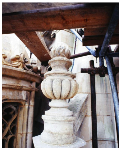
Basilique, clocher : détail ornemental, pot à feu.
