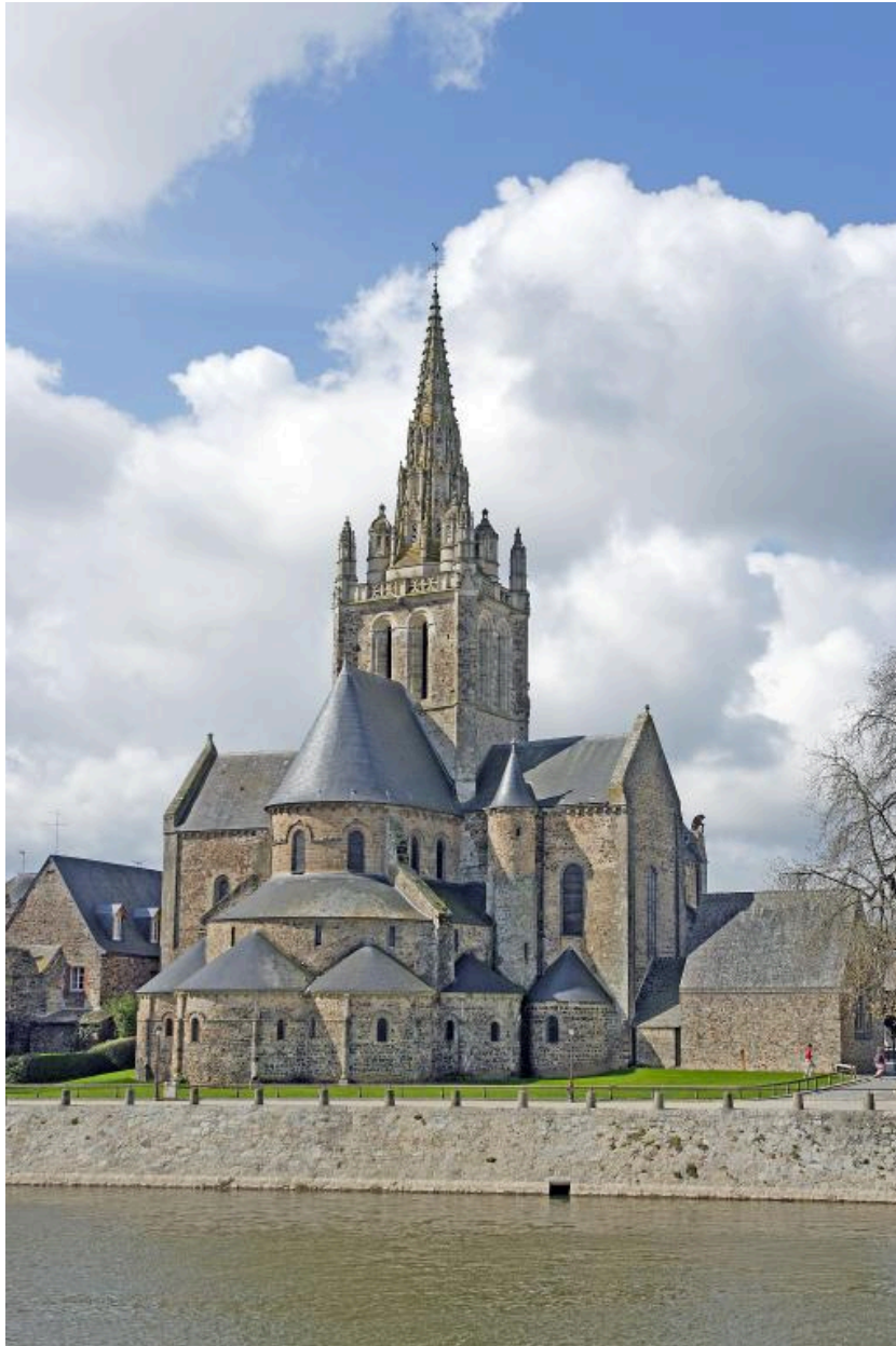
Chevet. Vue d'ensemble depuis le nord-est.
