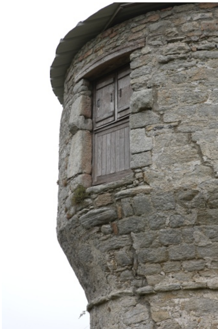
Cage, partie ouest. Détail de l'encorbellement et de la porte haute ouest.
