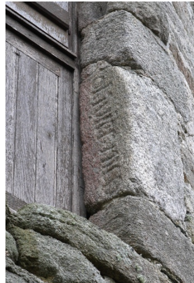
Cage, partie est, porte haute est, montant droit, partie inférieure. Détail de l'inscription : Olivier [MILD]. Phot. Denis Pillet IVR52_20074401243NUCA
