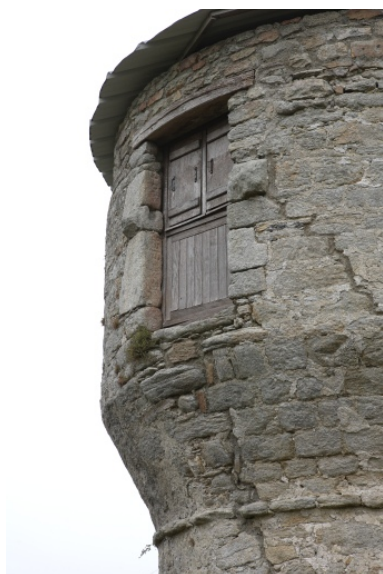
Cage, partie ouest. Détail de l'encorbellement et de la porte haute ouest. Phot. Denis Pillet IVR52_20074401240NUCA
