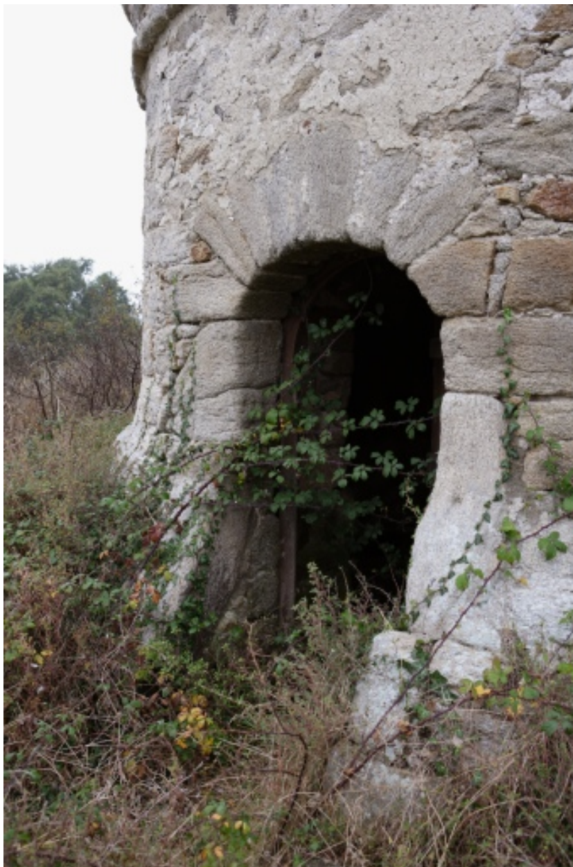
Tourelle, partie sud ; détail de la porte.
