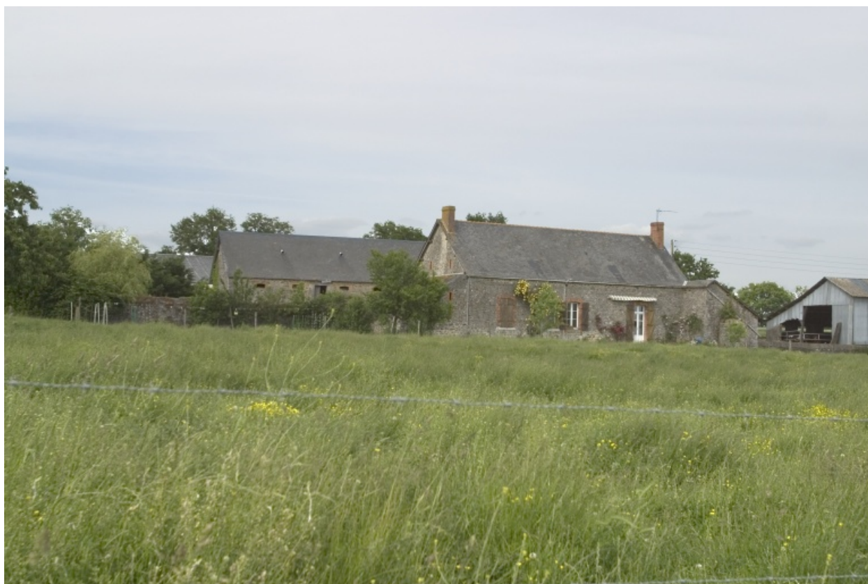
Vue d'ensemble depuis la route au sud.
