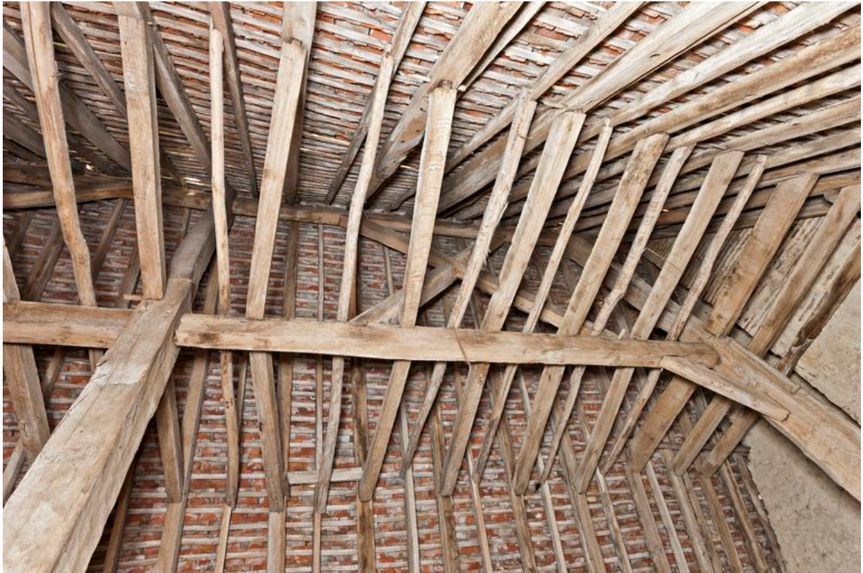
Détail du faitage de la charpente.
