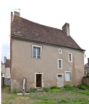
Elévation postérieure. Phot. Yves Guillotin IVR52_20137200450NUCA
