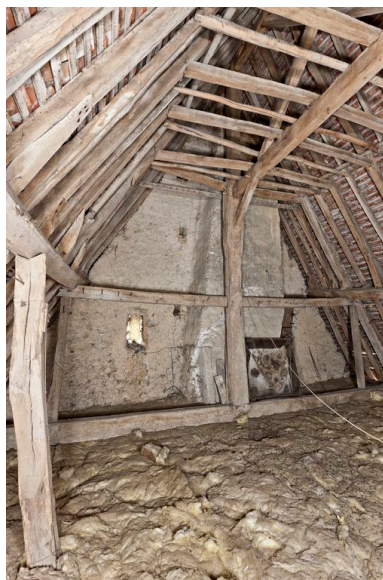
vue d'ensemble de la charpente.
