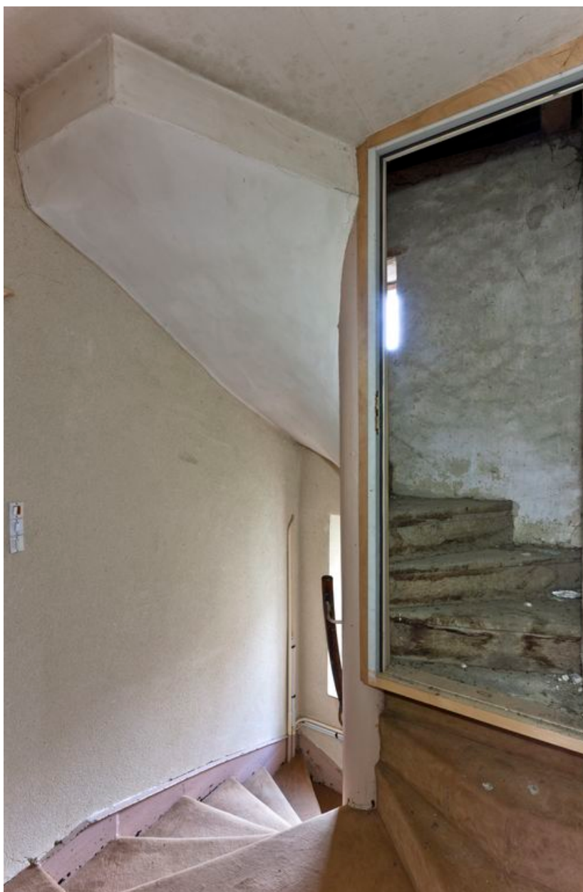
Vue de l'escalier en vis depuis l'étage.
