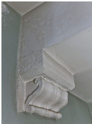
Console de la poutre du plafond de la pièce droite de l'étage.
