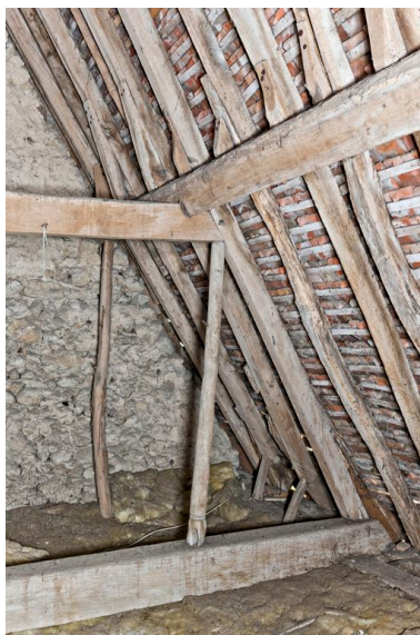
Détail de la charpente.
