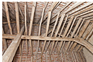
Détail du faitage de la charpente.
