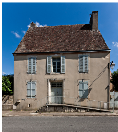
Elévation de la maison sur la rue. Phot. Yves Guillotin IVR52_20147202017NUCA
