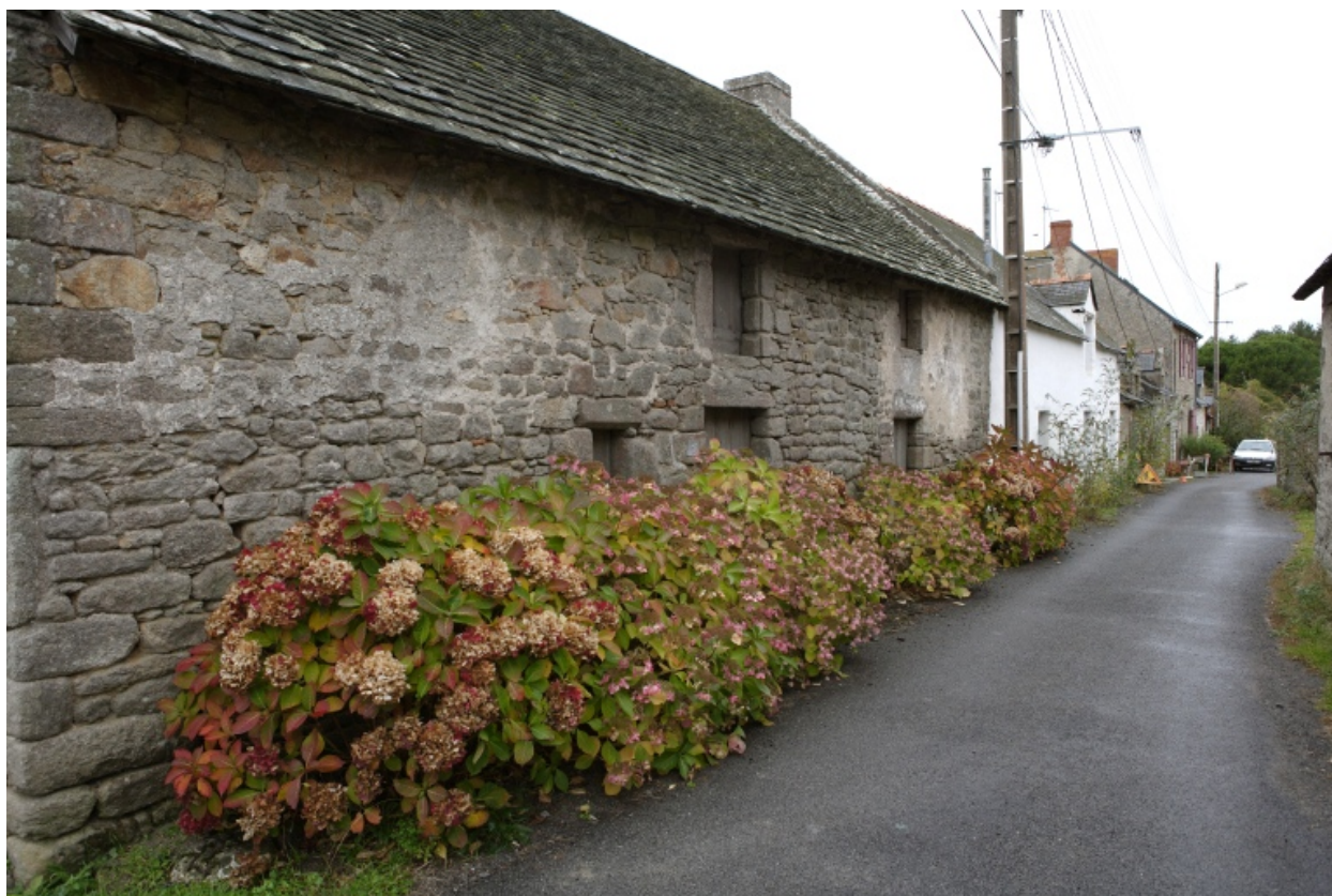
Vue d'ensemble de la rangée depuis l'est.
