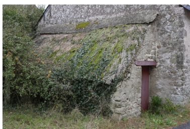
Toit à porcs couvert en chaume. Phot. Denis Pillet IVR52_20074401603NUCA
