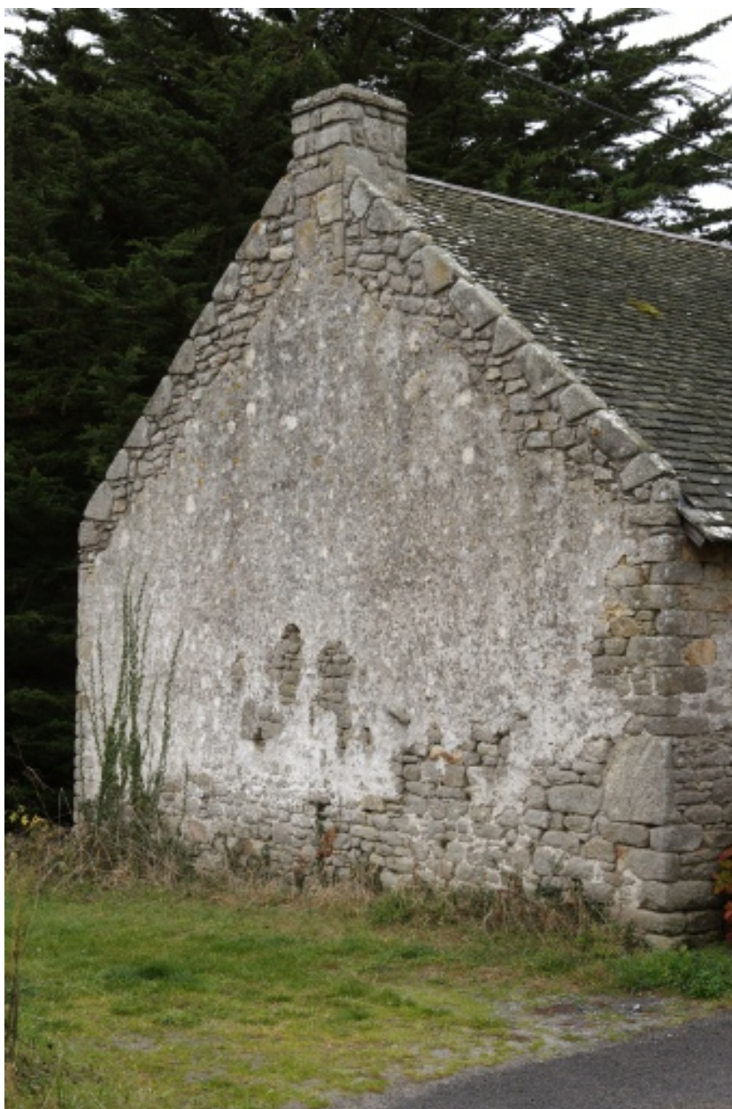
Détail du pignon remanié du n° 1.
