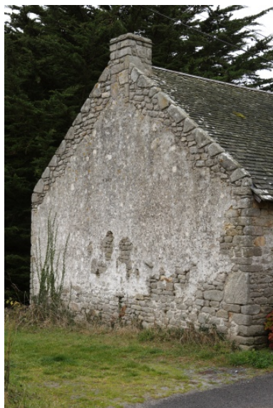
Détail du pignon remanié du n° 1. Phot. Denis Pillet IVR52_20074401591NUCA
