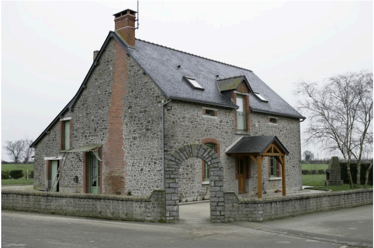
Le logis vu depuis le sud-ouest
