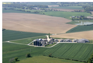
Vue aérienne d'ensemble depuis l'est. Phot. François Lasa IVR52_20075301926NUCA
