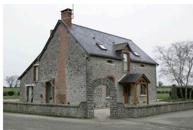
Le logis vu depuis le sud-ouest
