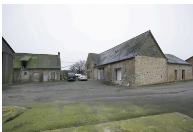
L'ancien logis-étable et l'étable vus depuis le nord.
