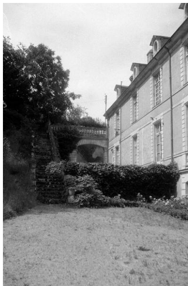
Château de Vaugirault. Vue de la façade arrière prise lors du pré-inventaire en 1972. Phot. Marie-Anne Eon IVR52_19724900561Z
