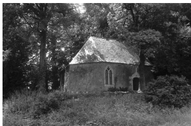
Château de Vaugirault. Vue de la chapelle prise lors du pré-inventaire en 1972. Phot. Marie-Anne Eon IVR52_19724900562Z
