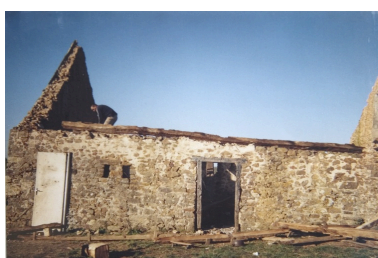
Photographie, années 1990 : vue partielle de l'étable pendant sa démolition. Phot. François Lasa IVR52_20045302178NUCAB
