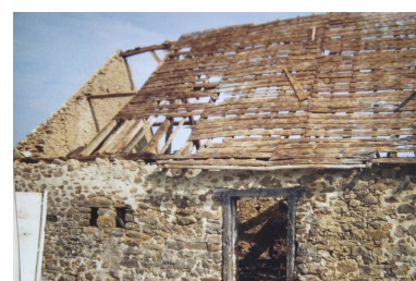
Photographie, années 1990 : l'étable pendant sa démolition. Repro. François Lasa IVR52_20045302177NUCAB
