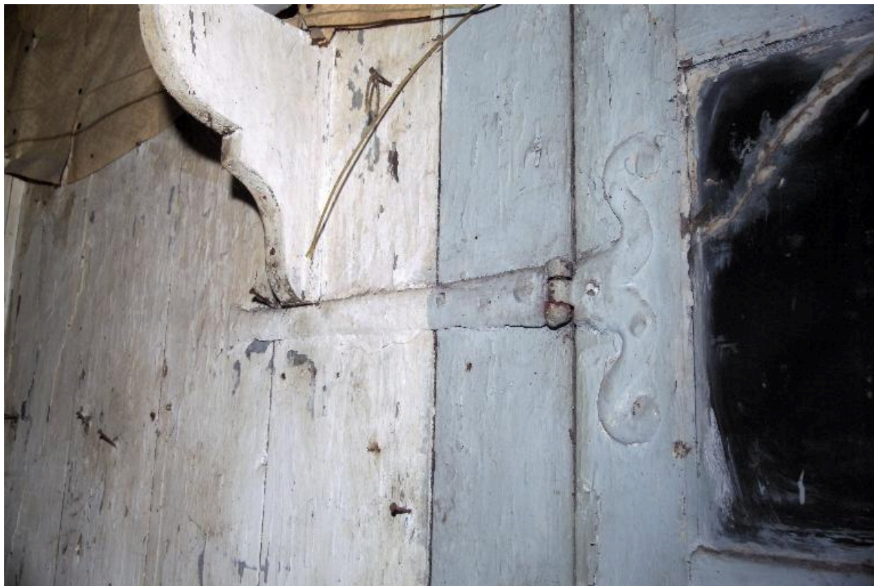
Le corps secondaire, premier étage, la pièce située au nord, détail.
