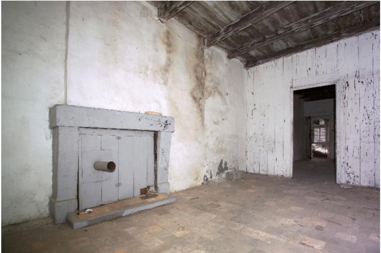
Le corps secondaire, premier étage, la première pièce accessible depuis l'escalier.
