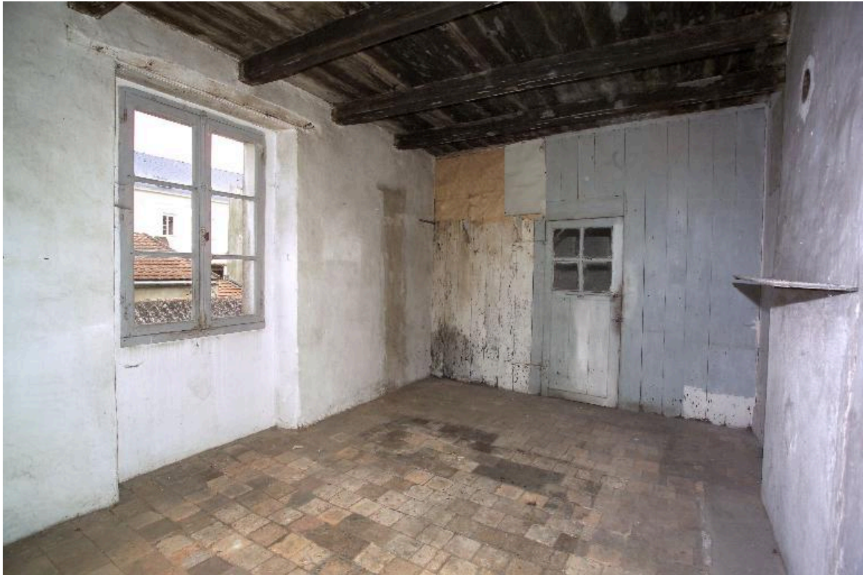
Le corps secondaire, premier étage, la pièce située au nord accessible à partir d'un escalier extérieur.
