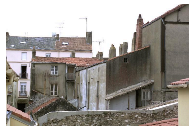
La façade postérieure du corps principal, le corps secondaire en appentis en retour à l'ouest, vue prise de l'immeuble n° 3, rue du Faisan. Phot. Denis Pillet IVR52_20034401478NUCA
