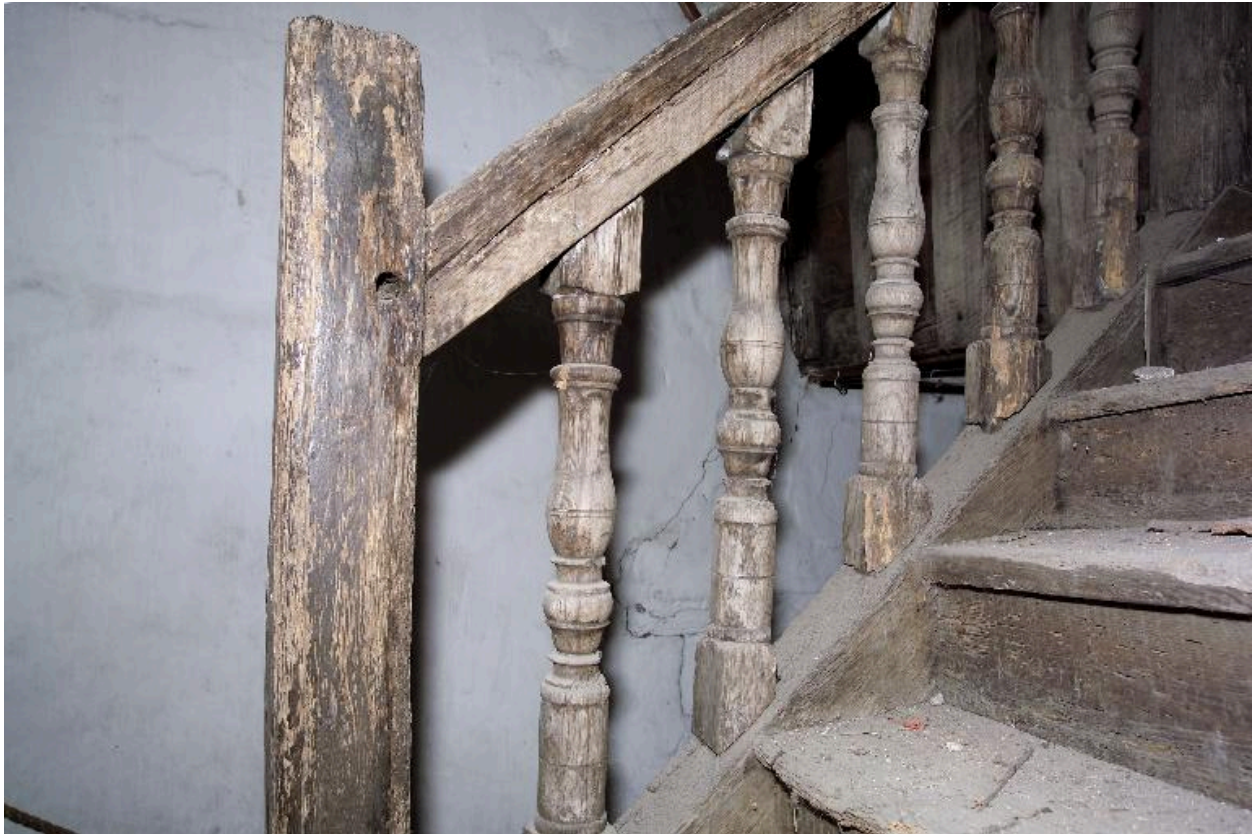
Détail des balustres de l'escalier.
