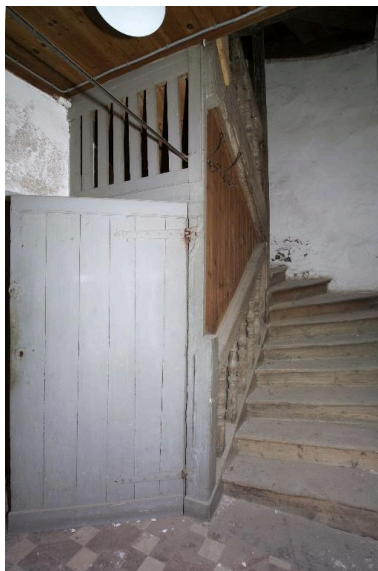
Le départ de l'escalier articulant les deux corps de bâtiment. Phot. Denis Pillet IVR52_20034401598NUCA
