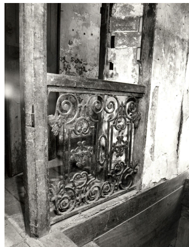
Cage d'escalier, palier du 1 er étage.
