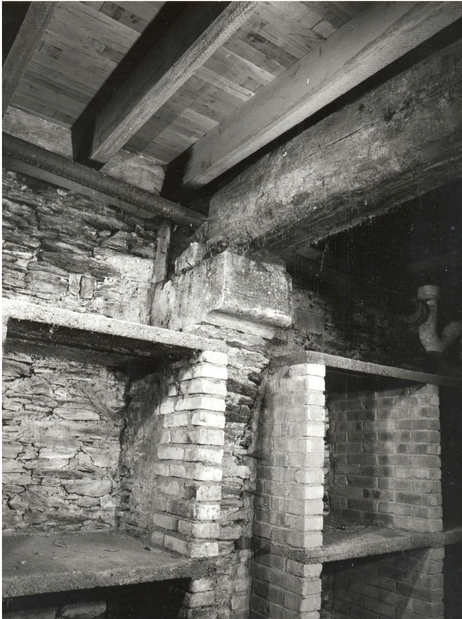
Sous-sol, cave antérieure : mur droit.
