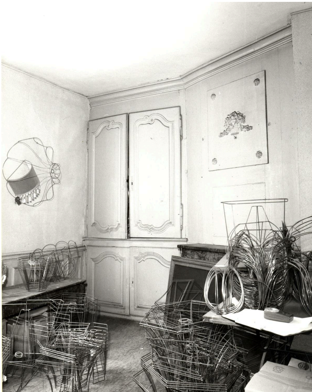
1er étage, pièce postérieure : mur postérieur.
