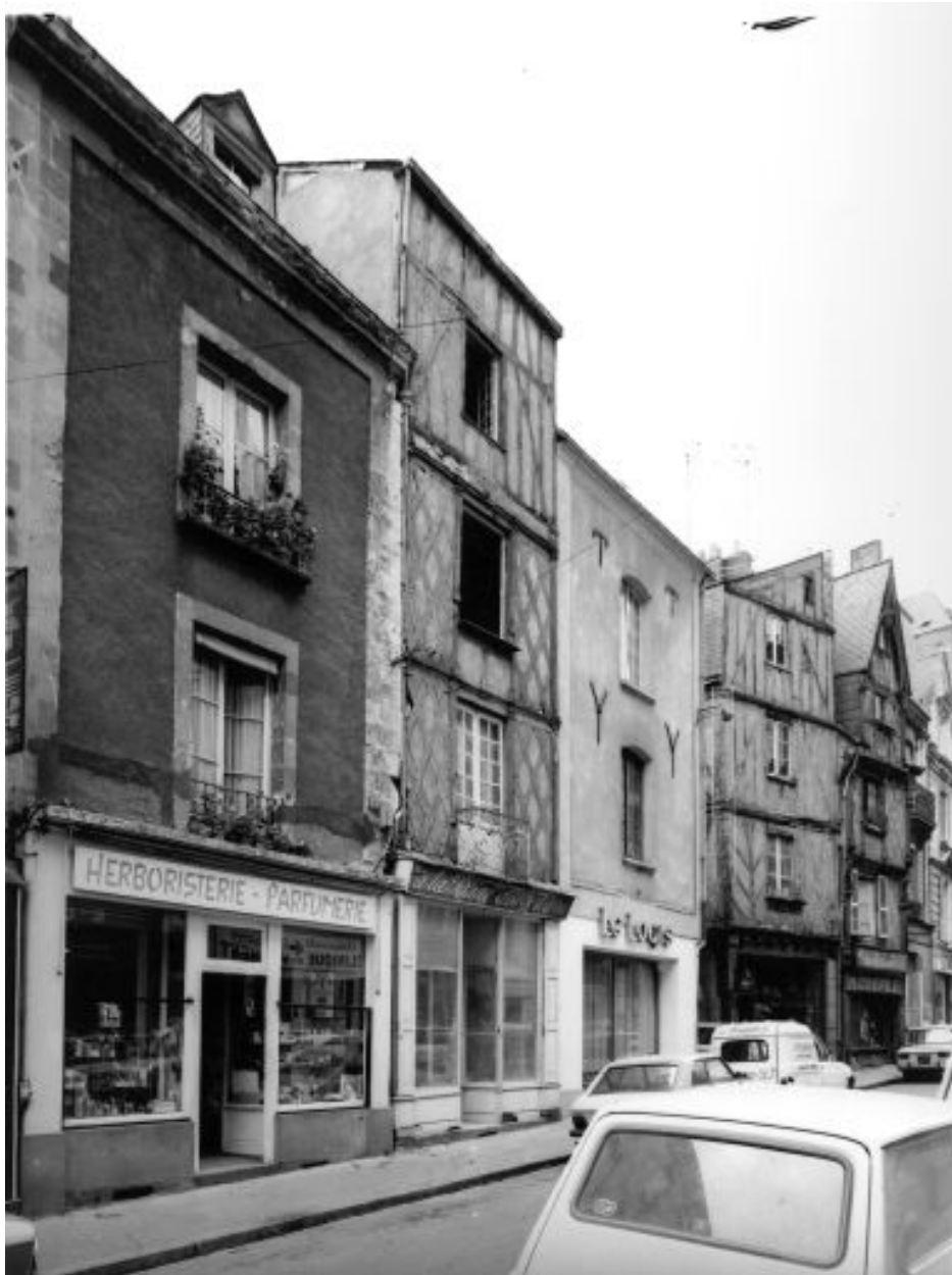
Rue Saint-Laud, façades n° 13 à 21.
