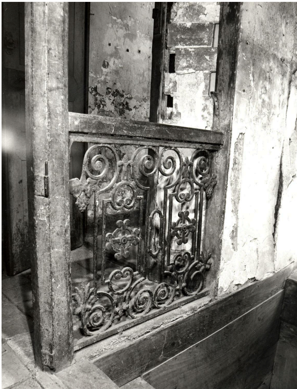
Cage d'escalier, palier du 1er étage.
