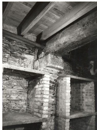
Sous-sol, cave antérieure : mur droit. Phot. Patrice Giraud IVR52_19844900658X
