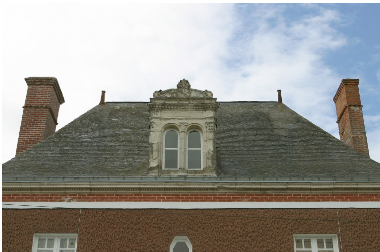
Le pan nord de la toiture et la lucarne.
