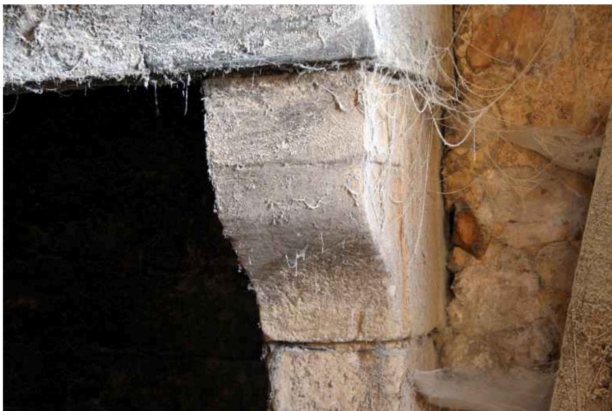
Salle à droite, cheminée : piédroit.
