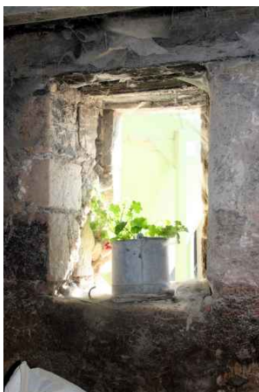
Salle à droite : baie sur la cour. Phot. Jean-Baptiste Darrasse IVR52_20067205891NUCA
