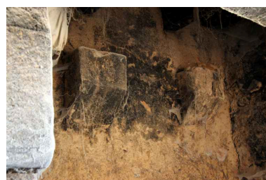
Salle à droite : corbeau sur le pignon pour soutenir une poutre de rive ? Phot. Jean-Baptiste Darrasse IVR52_20067205888NUCA
