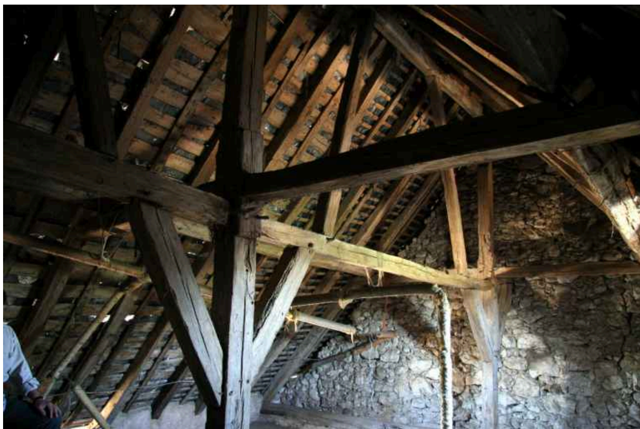
Charpente au dessus de la salle centrale.
