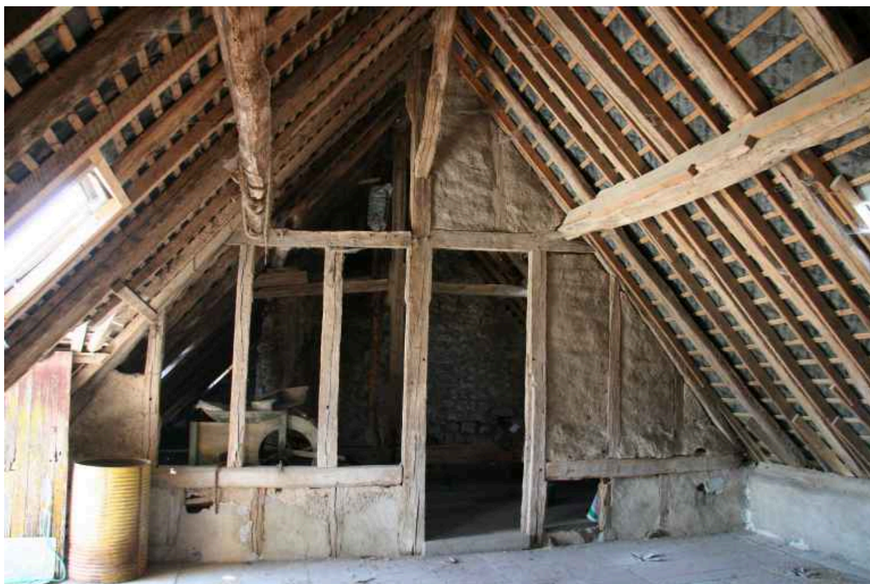
Comble au-dessus de la salle à droite : poursuite de la cloison en pan-de-bois et charpente à pannes à encoches.
