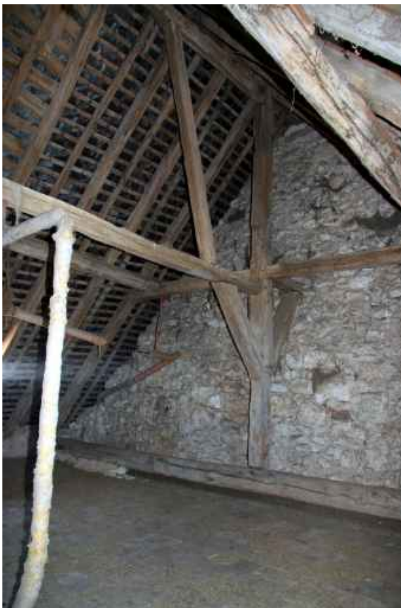
Comble de la salle centrale : charpente avec sous faîtage bas.
