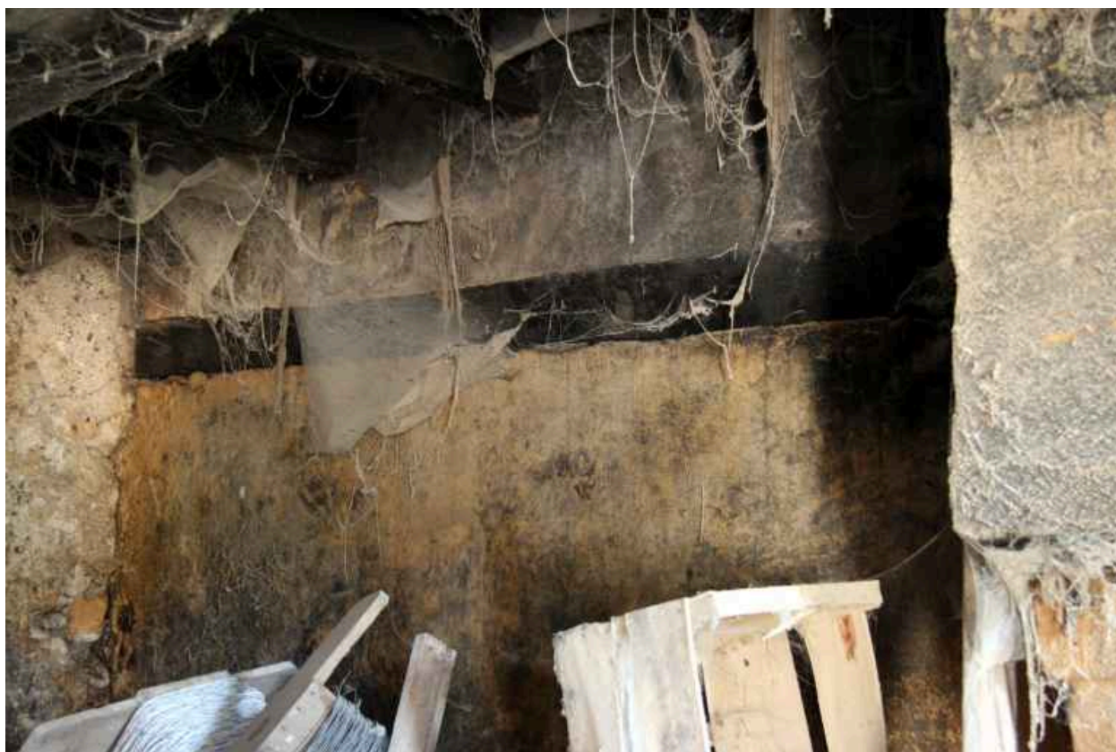
Salle à droite : poutre de rive sans corbeau dans le mur pignon.
