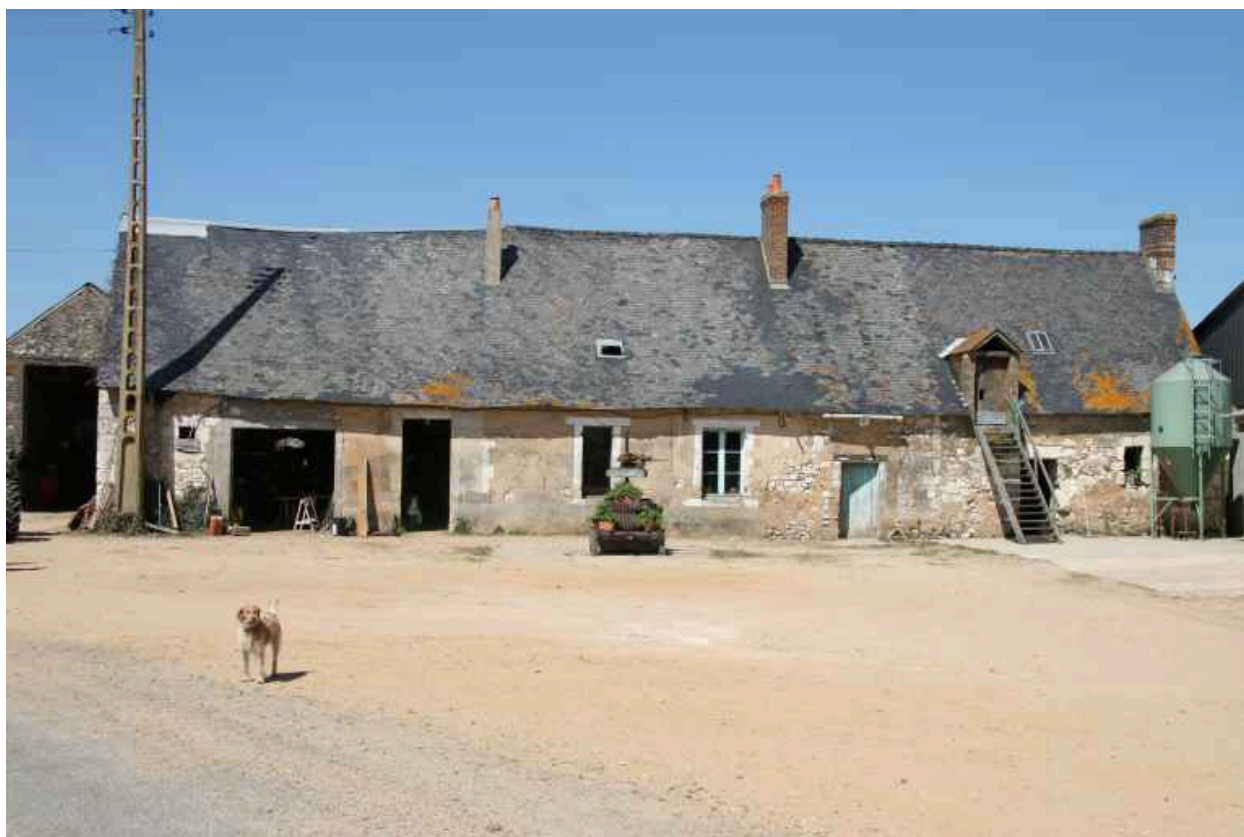
Façade antérieure sur cour.
