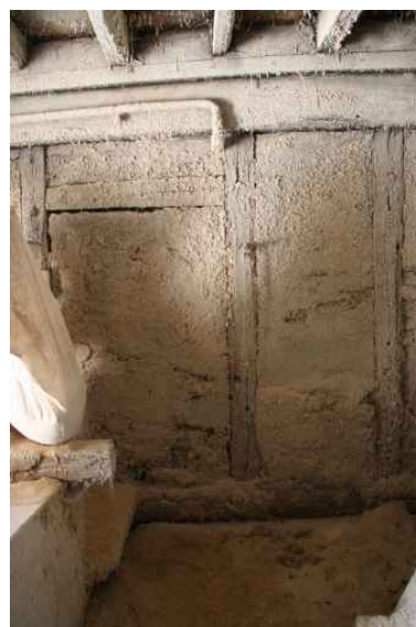
Salle à droite : cloison en pan de bois. Phot. Jean-Baptiste Darrasse IVR52_20067205892NUCA
