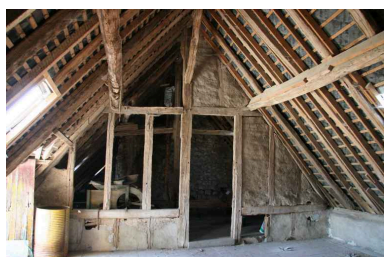
Comble au-dessus de la salle à droite : poursuite de la cloison en pan-de-bois et charpente à pannes à encoches. Phot. Jean-Baptiste Darrasse IVR52_20067205893NUCA
