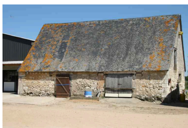
La grange étable. Phot. Jean-Baptiste Darrasse IVR52_20067205886NUCA
