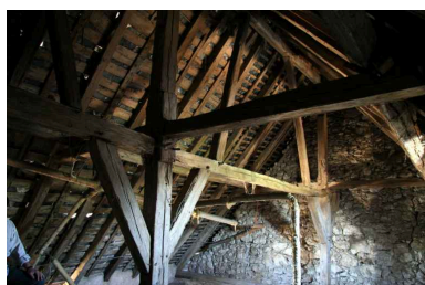
Charpente au dessus de la salle centrale. Phot. Jean-Baptiste Darrasse IVR52_20067205894NUCA
