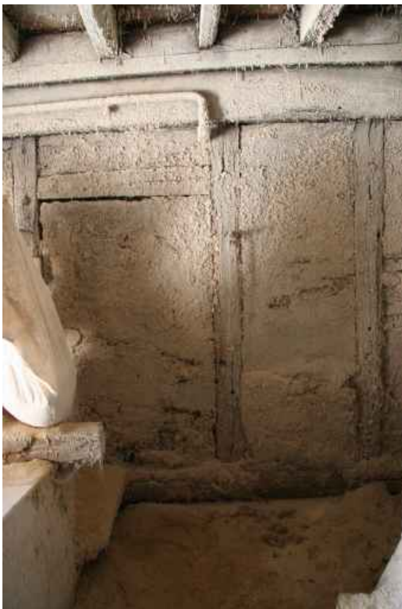
Salle à droite : cloison en pan de bois.
