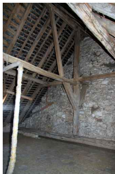
Comble de la salle centrale : charpente avec sous-faîtage bas. Phot. Jean-Baptiste Darrasse IVR52_20067205895NUCA
