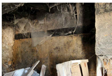
Salle à droite : poutre de rive sans corbeau dans le mur pignon. Phot. Jean-Baptiste Darrasse IVR52_20067205889NUCA
