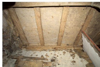
Plafond en bousillis visible au rez- de-chaussée de l'extension sud. Phot. Denis Pillet IVR52_20074400557NUCA
