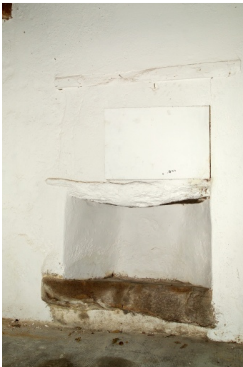
Evier du rez-de-chaussée sur le mur ouest.
