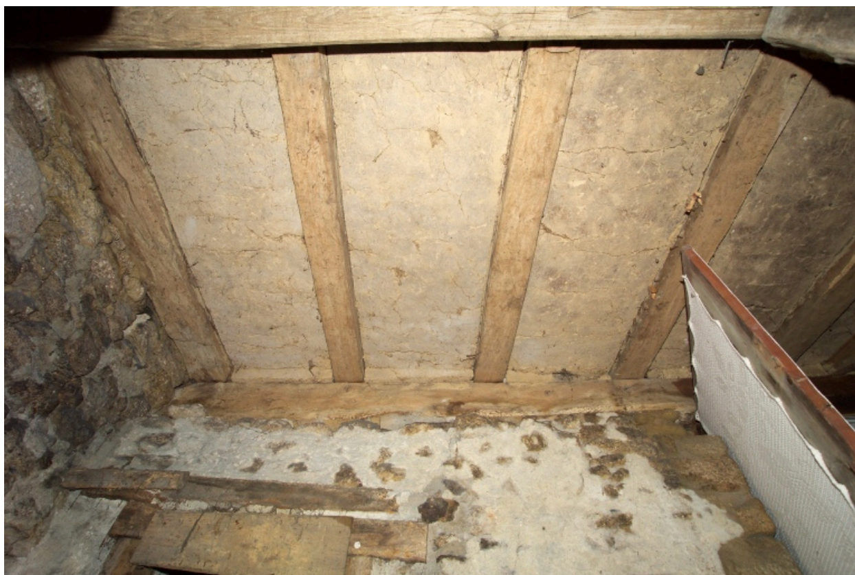
Plafond en bousillis visible au rez-de-chaussée de l'extension sud.
