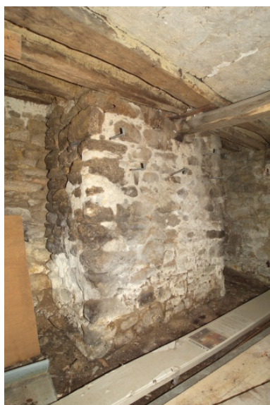
Soubassement de cheminée au rez-de-chaussée de l'extension sud. Phot. Denis Pillet IVR52_20074400558NUCA
