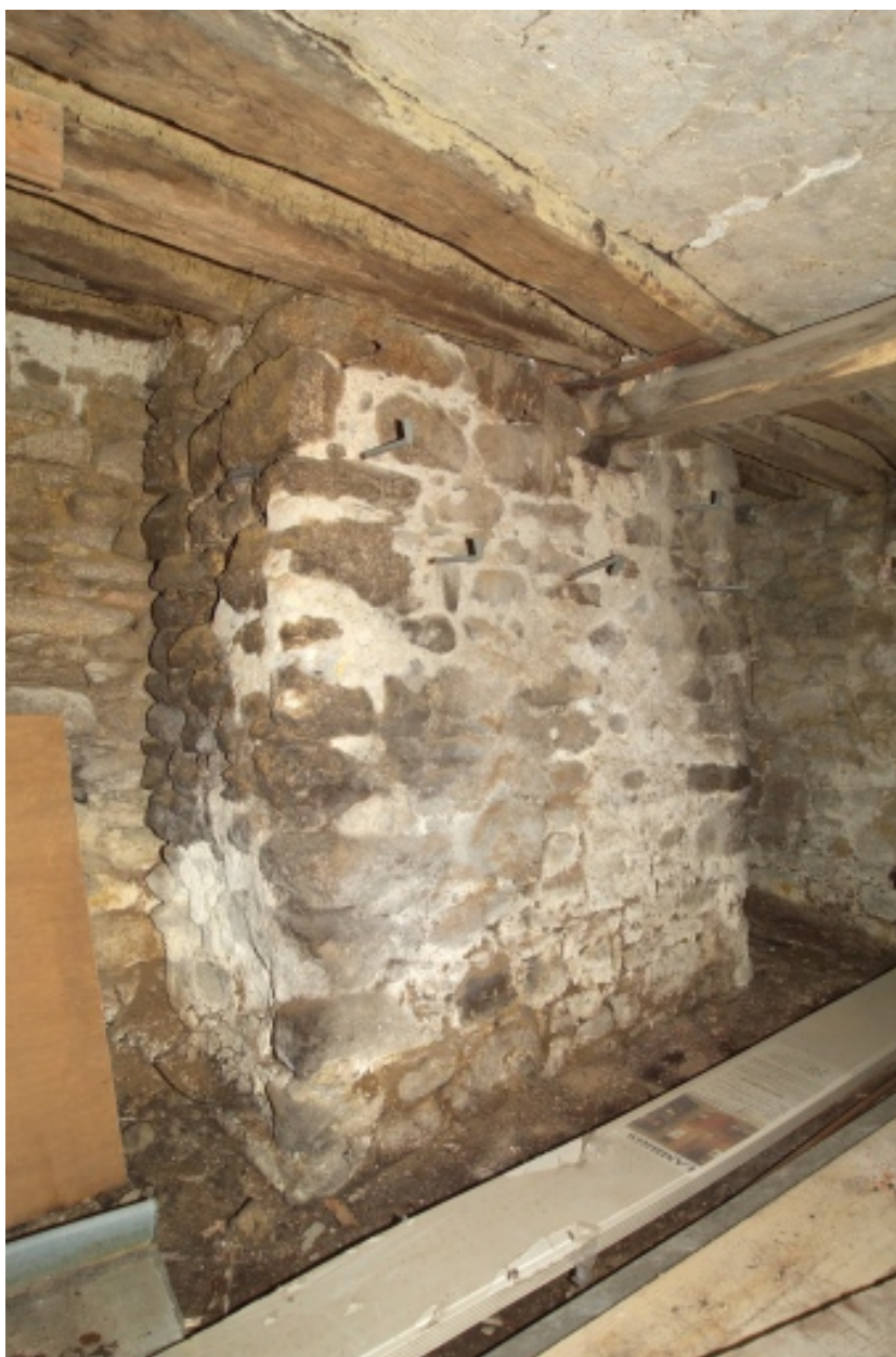
Soubassement de cheminée au rez-de-chaussée de l'extension sud.
