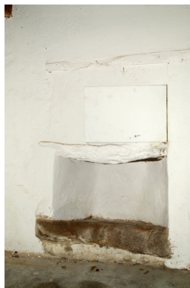
Evier du rez-de-chaussée sur le mur ouest. Phot. Denis Pillet IVR52_20074400560NUCA
