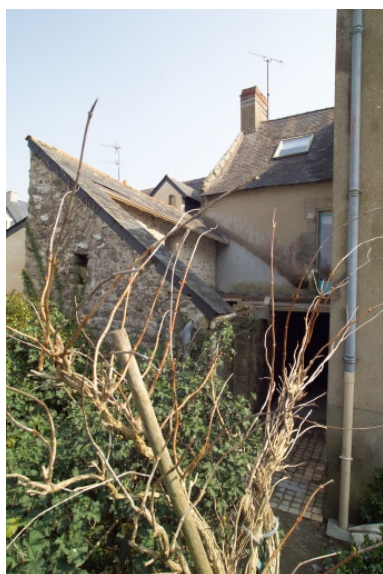
Détail de l'extension nord. Phot. Denis Pillet IVR52_20074400562NUCA
