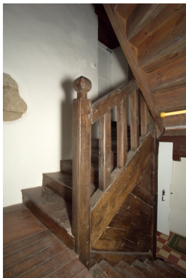
Détail de l'escalier. Phot. Denis Pillet IVR52_20074400567NUCA
