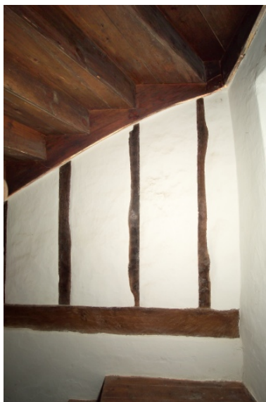
Cloison à pan de bois dans la cage d'escalier. Phot. Denis Pillet IVR52_20074400566NUCA
