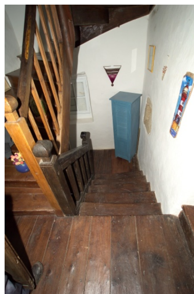
Vue de la cage d'escalier. Phot. Denis Pillet IVR52_20074400564NUCA
