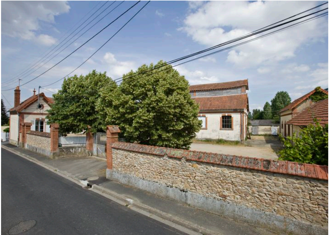
Vue d'ensemble des abattoirs prise du sud.
