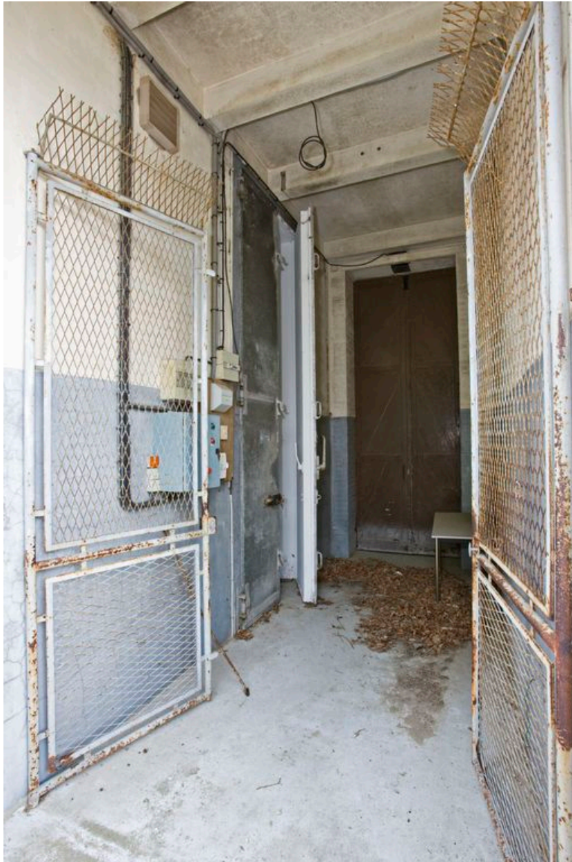
L'entrée de l'édicule en béton pour la salle réfrigérée.
