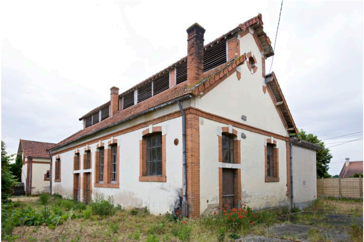
Le bâtiment principal : façade postérieure.
