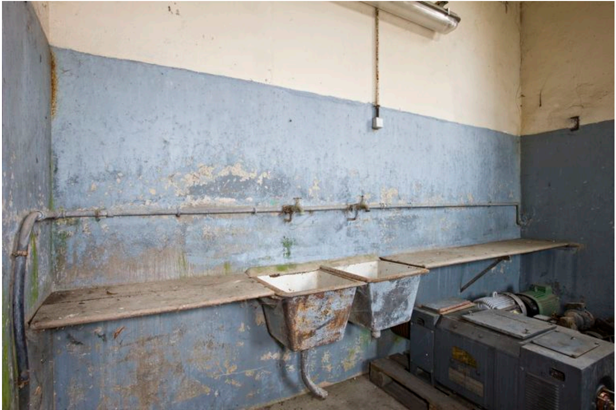
Bâtiment principal, la charcuterie : les évier.
