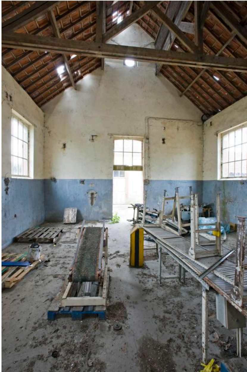
La salle d'abattage : vue d'ensemble vers l'entrée.
