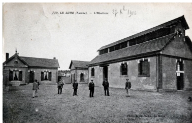
Vue d'ensemble de l'abattoirs depuis la cour antérieure. Autr. A. Dolbeau, Phot. Jean- Baptiste (reproduction) Darrasse IVR52_20067207323NUCA
