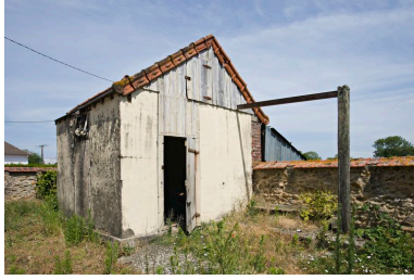
Petite dépendance dans l'angle nord-ouest. Phot. Yves Guillotin IVR52_20117200747NUCA
