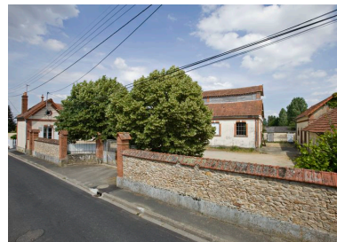
Vue d'ensemble des abattoirs prise du sud. Phot. Yves Guillotin IVR52_20117200770NUCA
