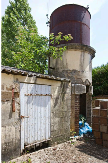
Angle nord-est de la cour : château d'eau. Phot. Yves Guillotin IVR52_20117200748NUCA
