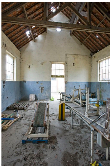
La salle d'abattage : vue d'ensemble vers l'entrée. Phot. Yves Guillotin IVR52_20117200717NUCA
