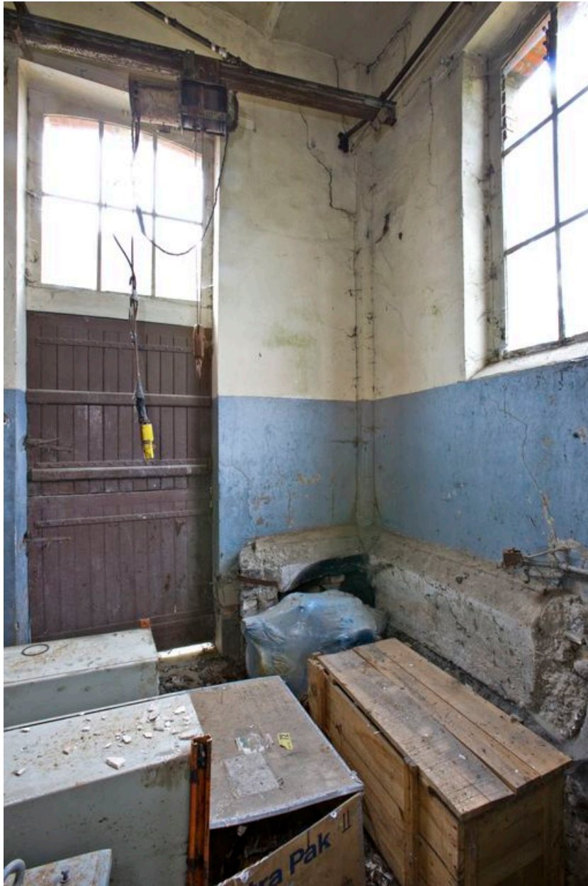
Bâtiment principal, la charcuterie : vestiges de cuve en béton.
