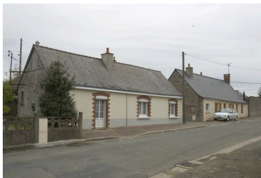
Vue depuis la rue. La maison est à gauche. Phot. François Lasa IVR52_20045303309NUCA
