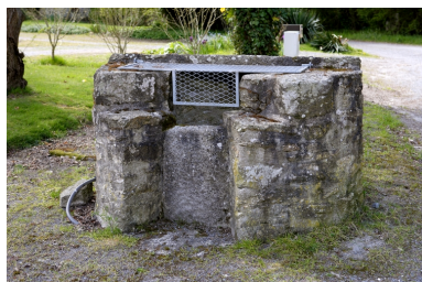
Puits (rue de la Butte). Phot. Denis Pillet IVR52_20084401407NUCA
