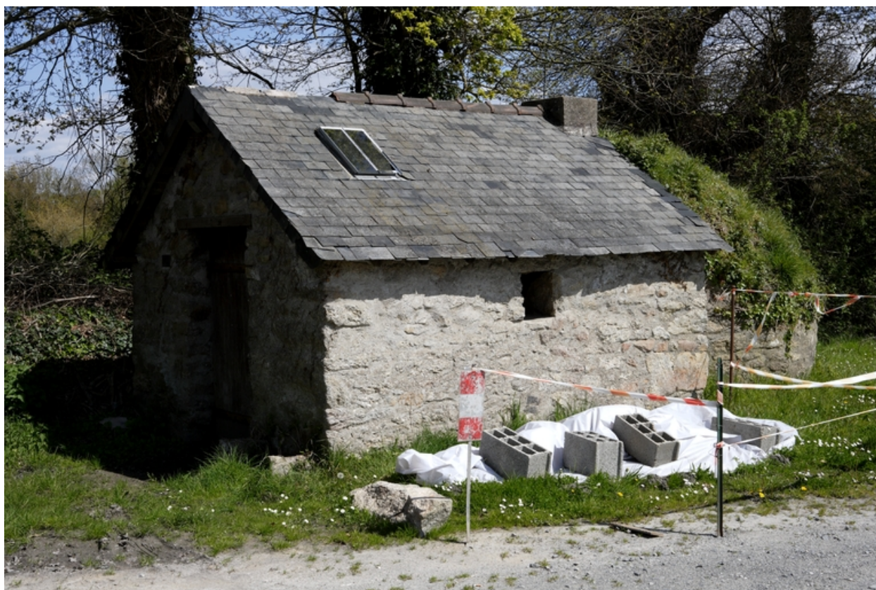
Fournil (rue du Pont).
