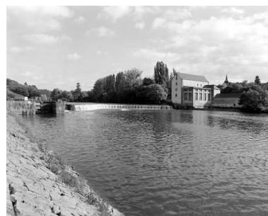
Vue d'ensemble du site depuis la rive droite, en aval : écluse, pertuis, barrage, moulin de port Rhingear, actuellement centrale hydroélectrique.
