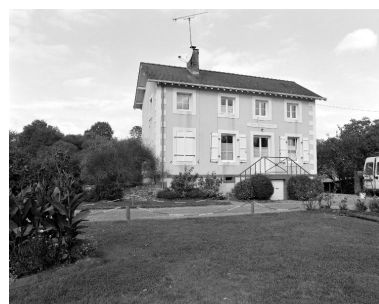
La maison éclusière.
