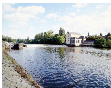
Vue d'ensemble du site depuis la rive droite, en aval : écluse, pertuis, barrage, moulin de port Rhingear, actuellement centrale hydroélectrique.
