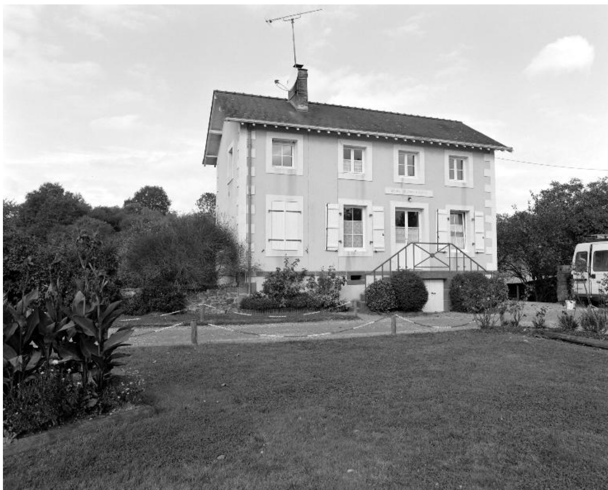
La maison éclusière.
