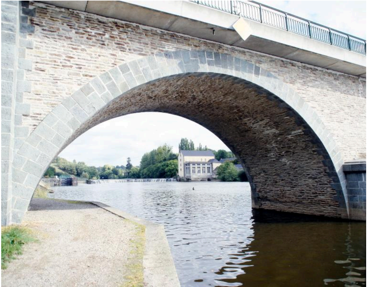
Vue d'ensemble du site à travers la première arche du pont d'Entrammes, situé en aval.
