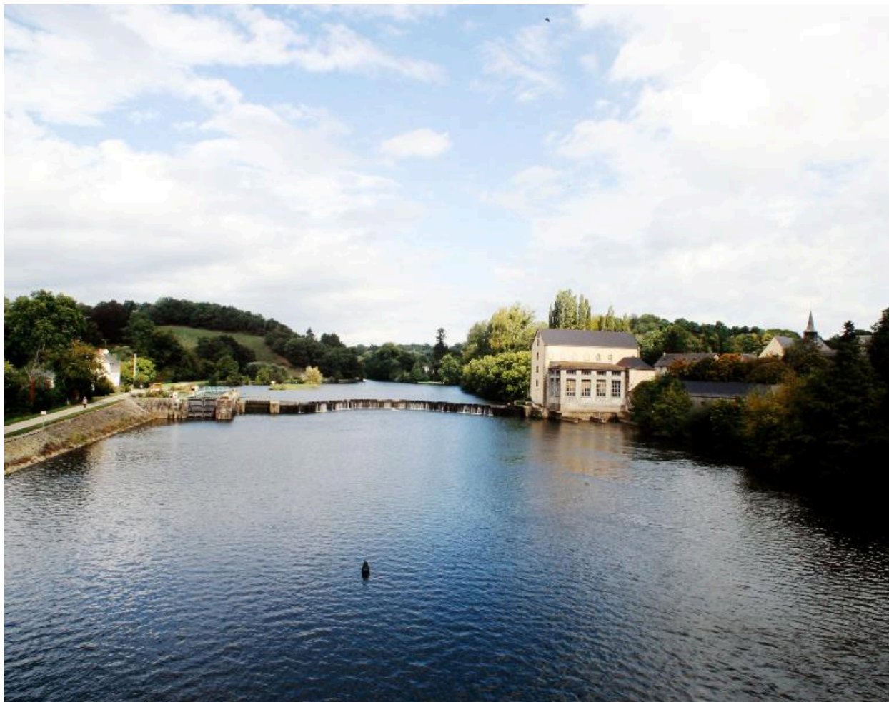
Vue d'ensemble du site depuis le pont d'Entrammes, situé en aval ; maison éclusière, écluse, pertuis, barrage, moulin de port Rhingear, actuellement centrale hydroélectrique, église de l'abbaye du Port du Salut.
