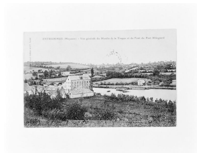
Vue d'ensemble depuis le nord-est. A gauche, le moulin (façades nord et est). Phot. Désiré et Henriette Hamel-Jallier, Repro. François Lasa IVR52_20025300047X
