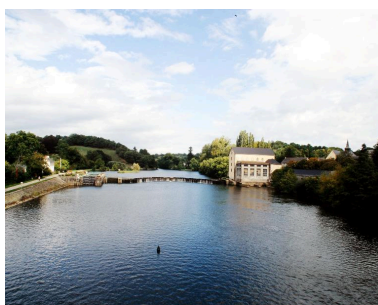
Vue d'ensemble du site depuis le pont d'Entrammes, situé en aval ; maison éclusière, écluse, pertuis, barrage, moulin de port Rhingear, actuellement centrale hydroélectrique, église de l'abbaye du Port du Salut.
