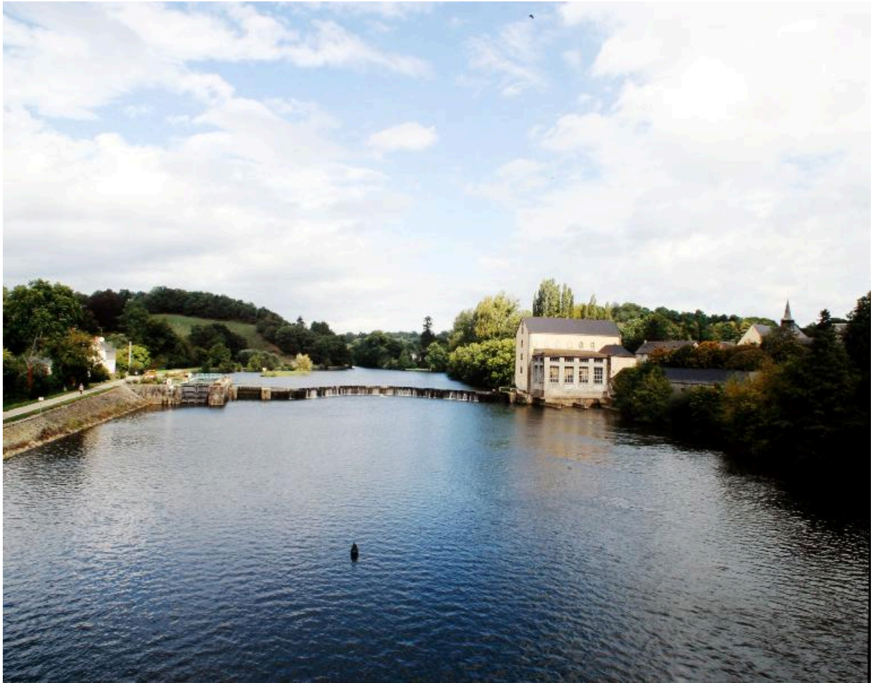
Vue d'ensemble du site depuis le pont d'Entrammes, situé en aval ; maison éclusière, écluse, pertuis, barrage, moulin de port Rhingear, actuellement centrale hydroélectrique, église de l'abbaye du Port du Salut.
