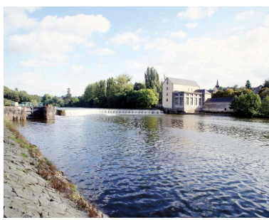
Vue d'ensemble du site depuis la rive droite, en aval : écluse, pertuis, barrage, moulin de port Rhingear, actuellement centrale hydroélectrique.
