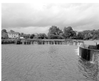
Vue d'ensemble du site depuis le moulin, situé sur la rive gauche : maison éclusière, écluse, barrage.
