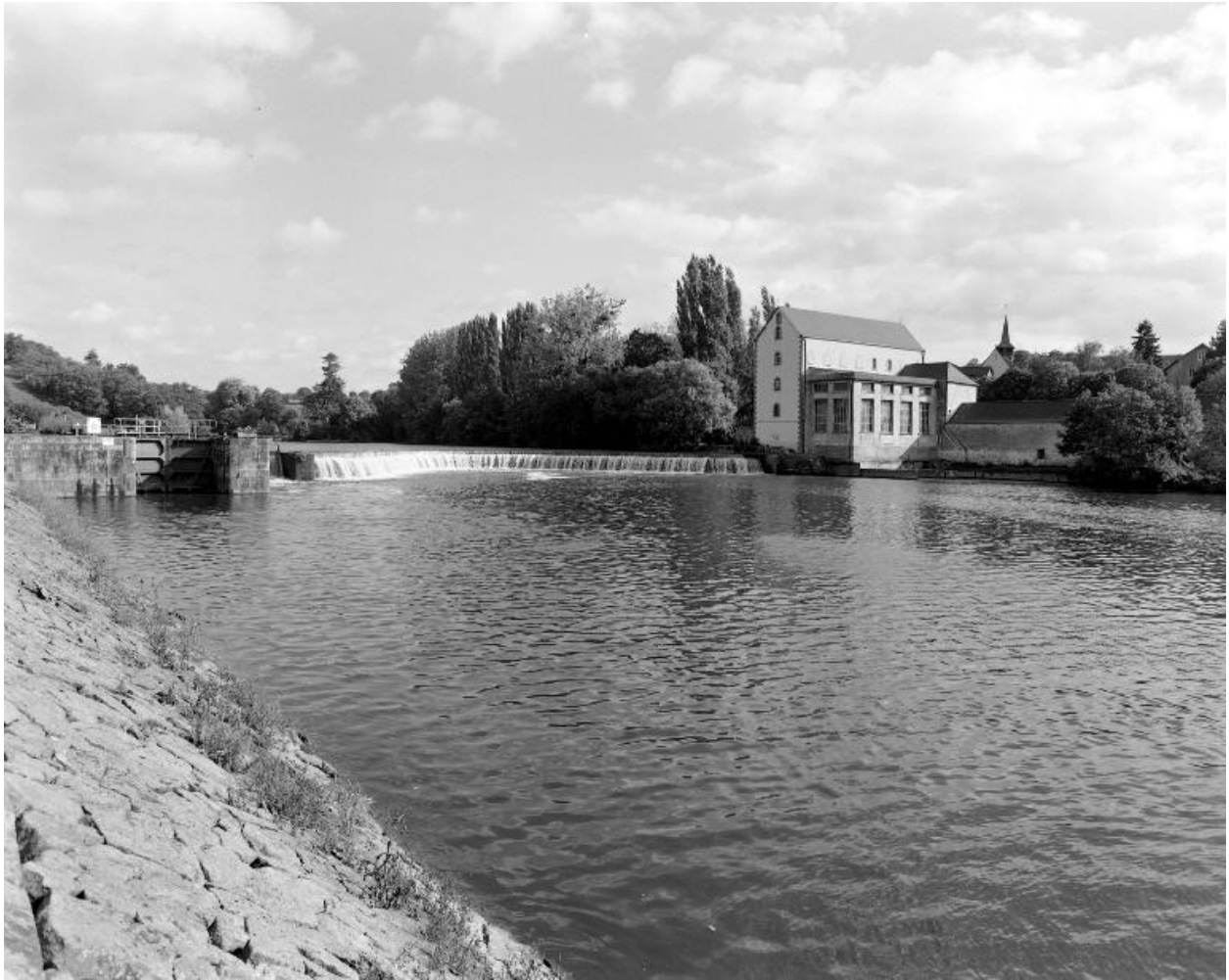
Vue d'ensemble du site depuis la rive droite, en aval : écluse, pertuis, barrage, moulin de port Rhingear, actuellement centrale hydroélectrique.
