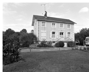
La maison éclusière. Phot. François Lasa IVR52_20015300482X
