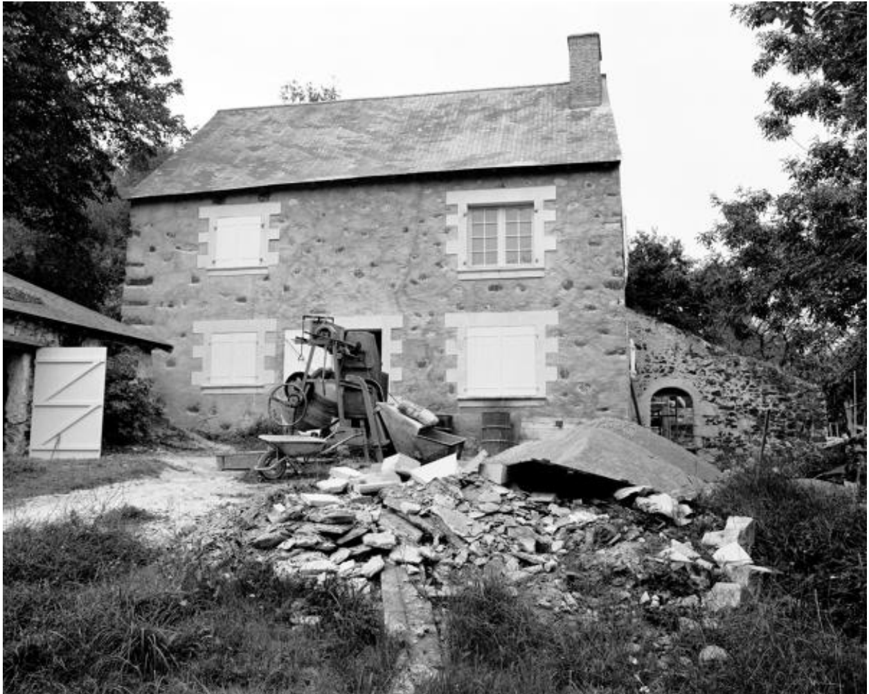
Première maison, façade antérieure, 1985.
