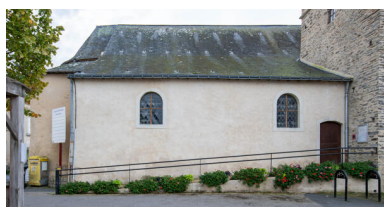
La chapelle nord. Repro. Pierre-Bernard Fourny IVR52_20225300967NUCA
