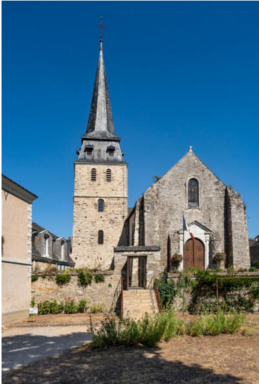
La façade occidentale et le clocher.
