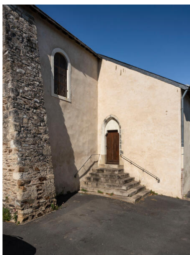
La chapelle sud. Phot. Thierry Seldubuisson IVR52_20225300845NUCA
