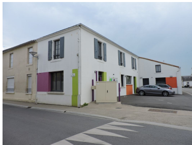
La crèche, ancien bureau de poste, vue depuis le nord. Phot. Yannis Suire IVR52_20198502445NUCA
