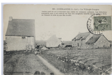
Vue de l'écart de Congor au début du XXe siècle. Phot. Denis (reproduction) Pillet IVR52_20074401904NUCA
