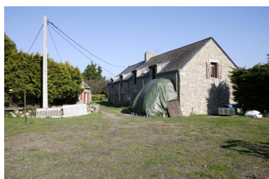
Vue d'ensemble depuis le sud. Phot. Denis Pillet IVR52_20084400181NUCA
