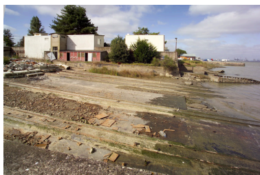
Vue d'ensemble du chantier naval. Phot. Denis Pillet IVR52_20044401932NUCA
