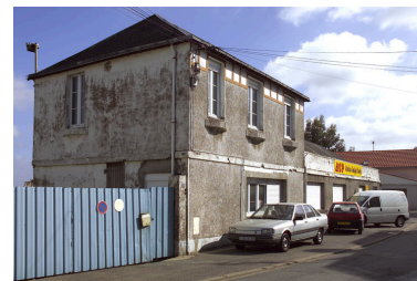
Vue d'ensemble vers l'amont depuis la rue. Phot. Denis Pillet IVR52_20044401912NUCA
