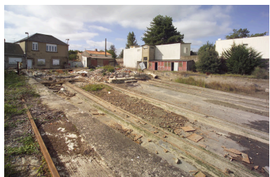
Vue du chantier depuis la rive. Phot. Denis Pillet IVR52_20044401933NUCA
