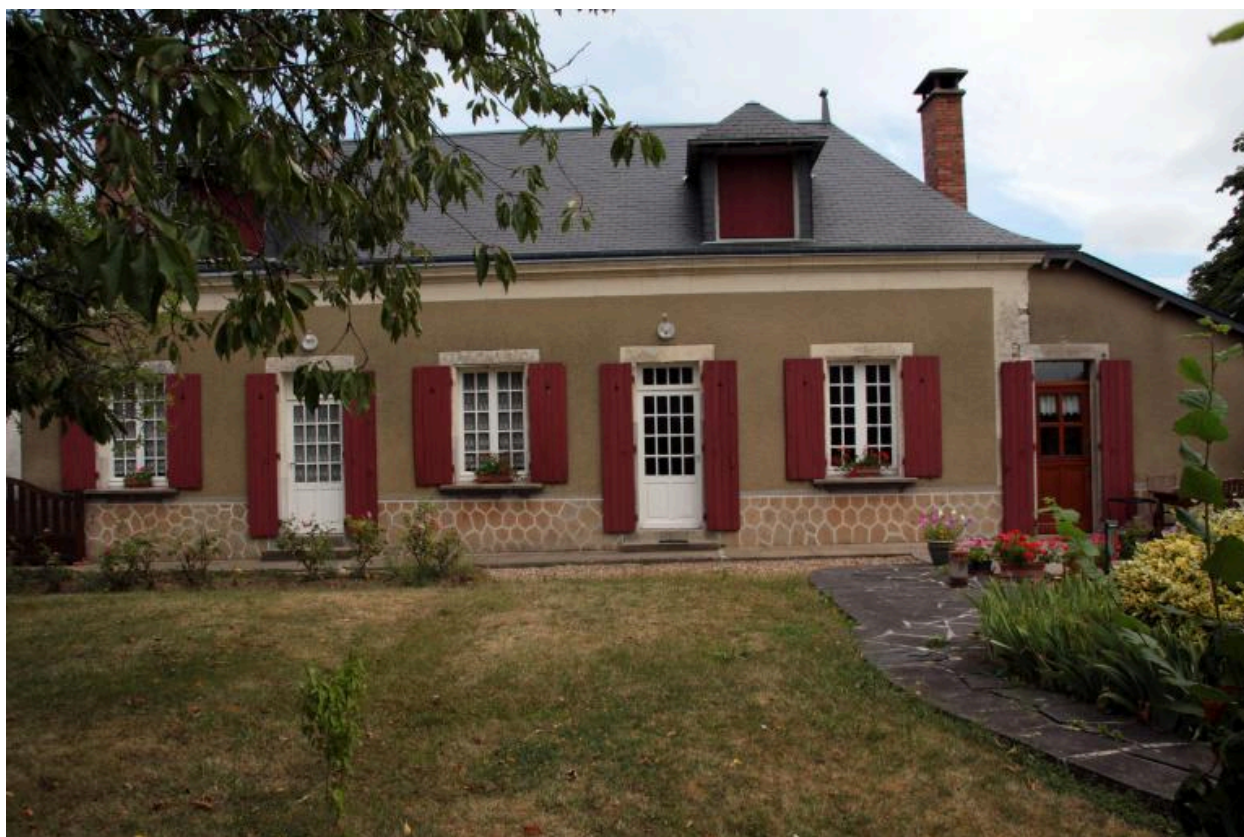
Maison : façade antérieure.
