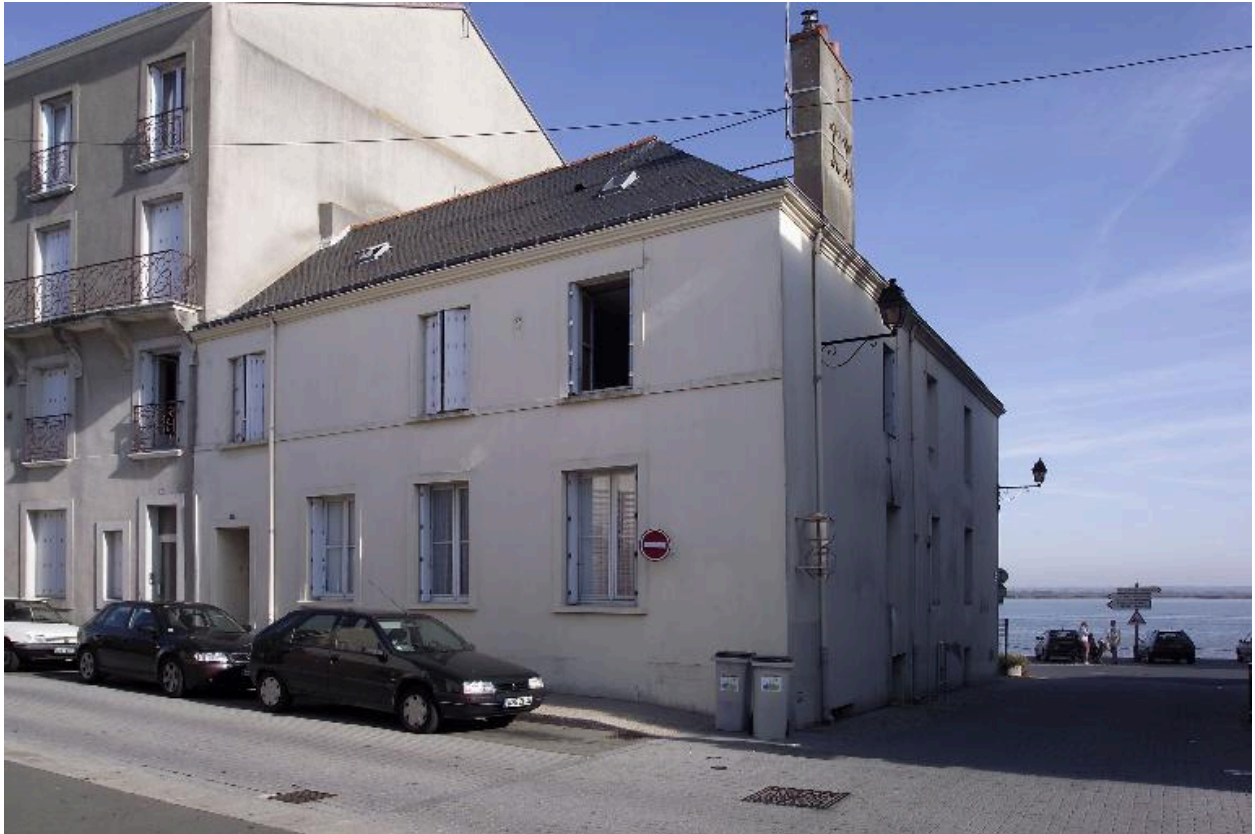
Vue des façades sur la rue du Général-De-Gaulle et sur la rue Pasteur.
