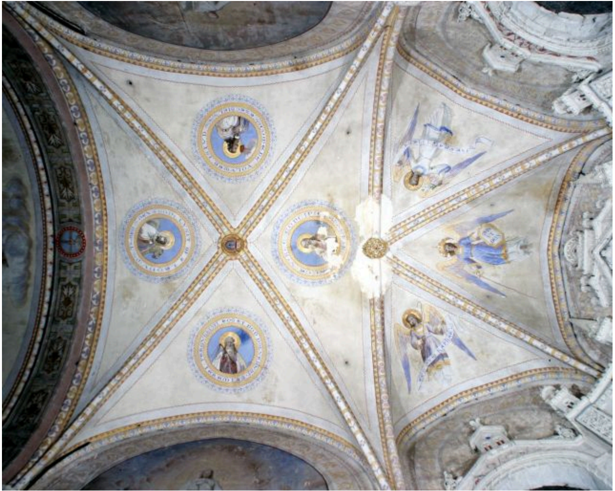
Vue d'ensemble de la voûte du choeur.
