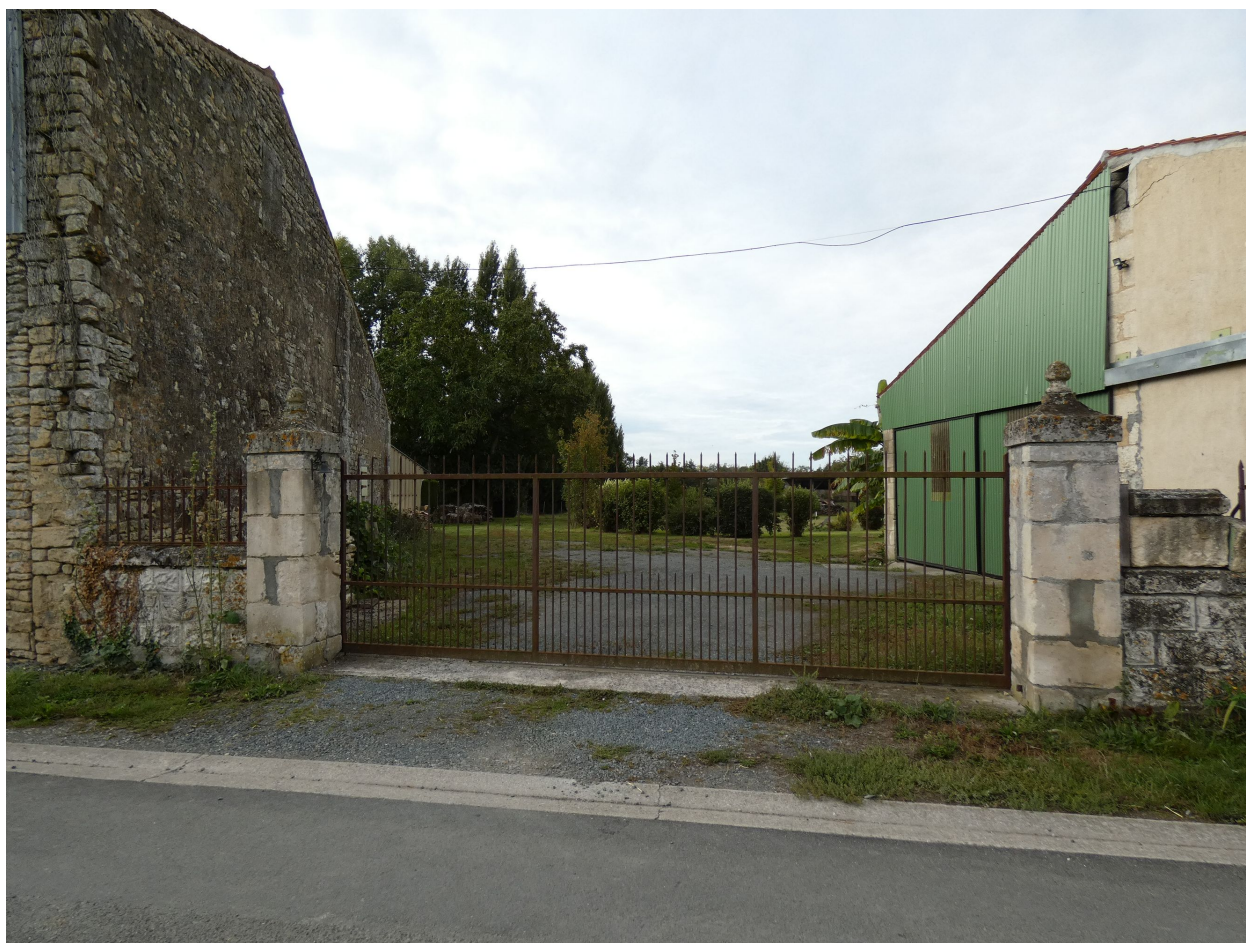
Le portail vu depuis le nord.
