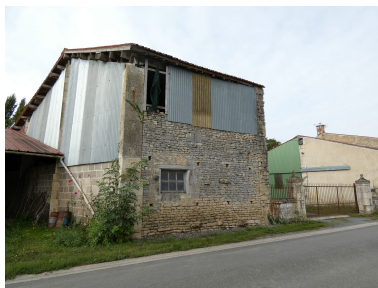
L'étable surmontée d'un fenil vue depuis le nord-est. Phot. Yannis Suire IVR52_20228500589NUCA
