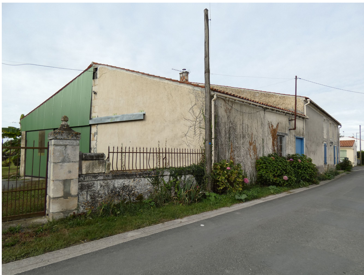
La grange dans le prolongement du logis, vue depuis l'est.
