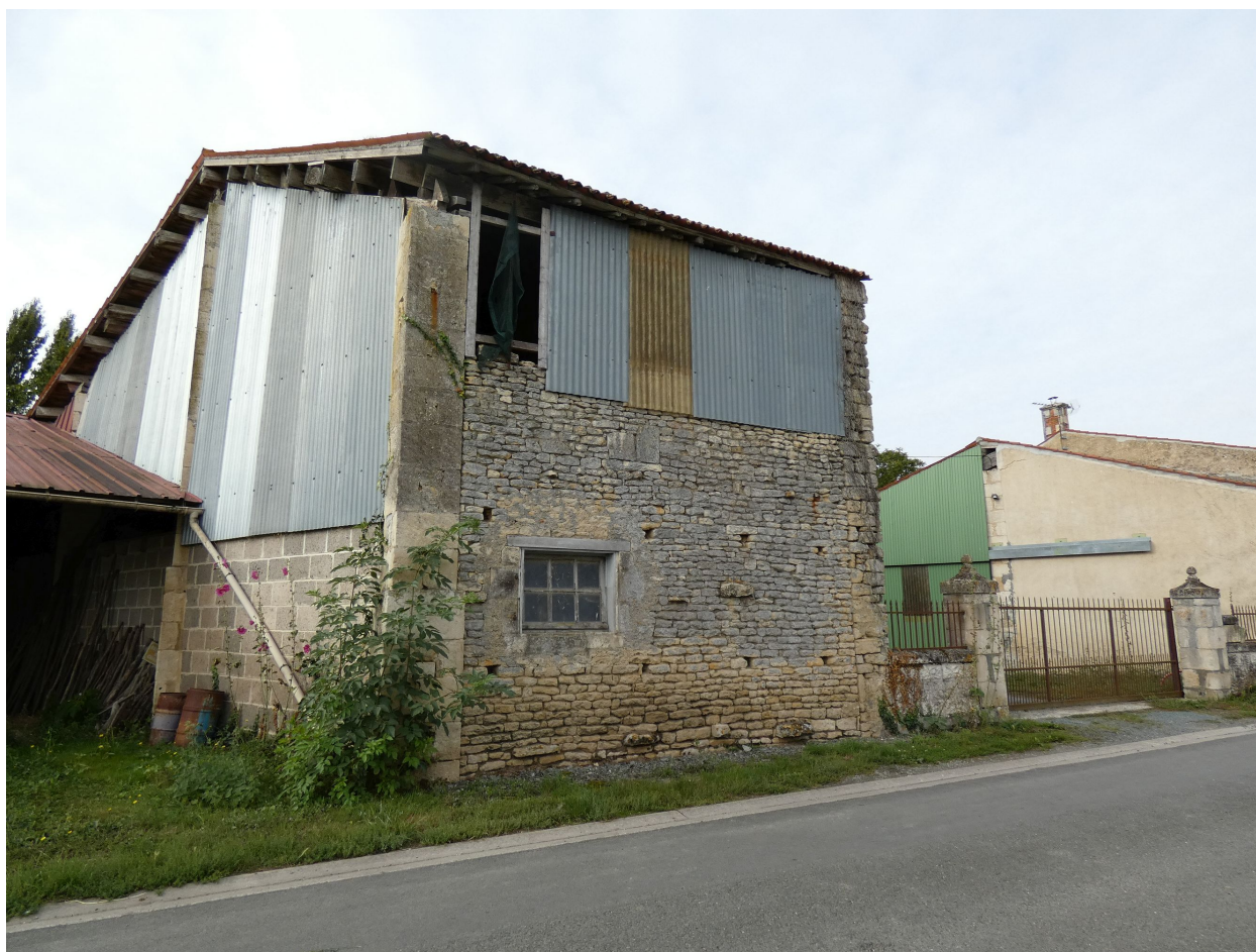
L'étable surmontée d'un fenil vue depuis le nord-est.
