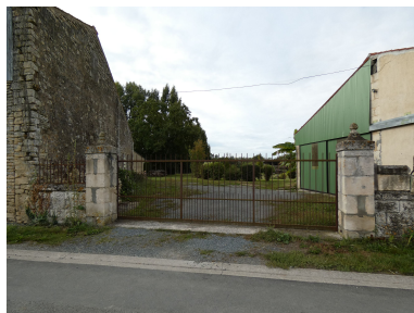
Le portail vu depuis le nord. Phot. Yannis Suire IVR52_20228500587NUCA
