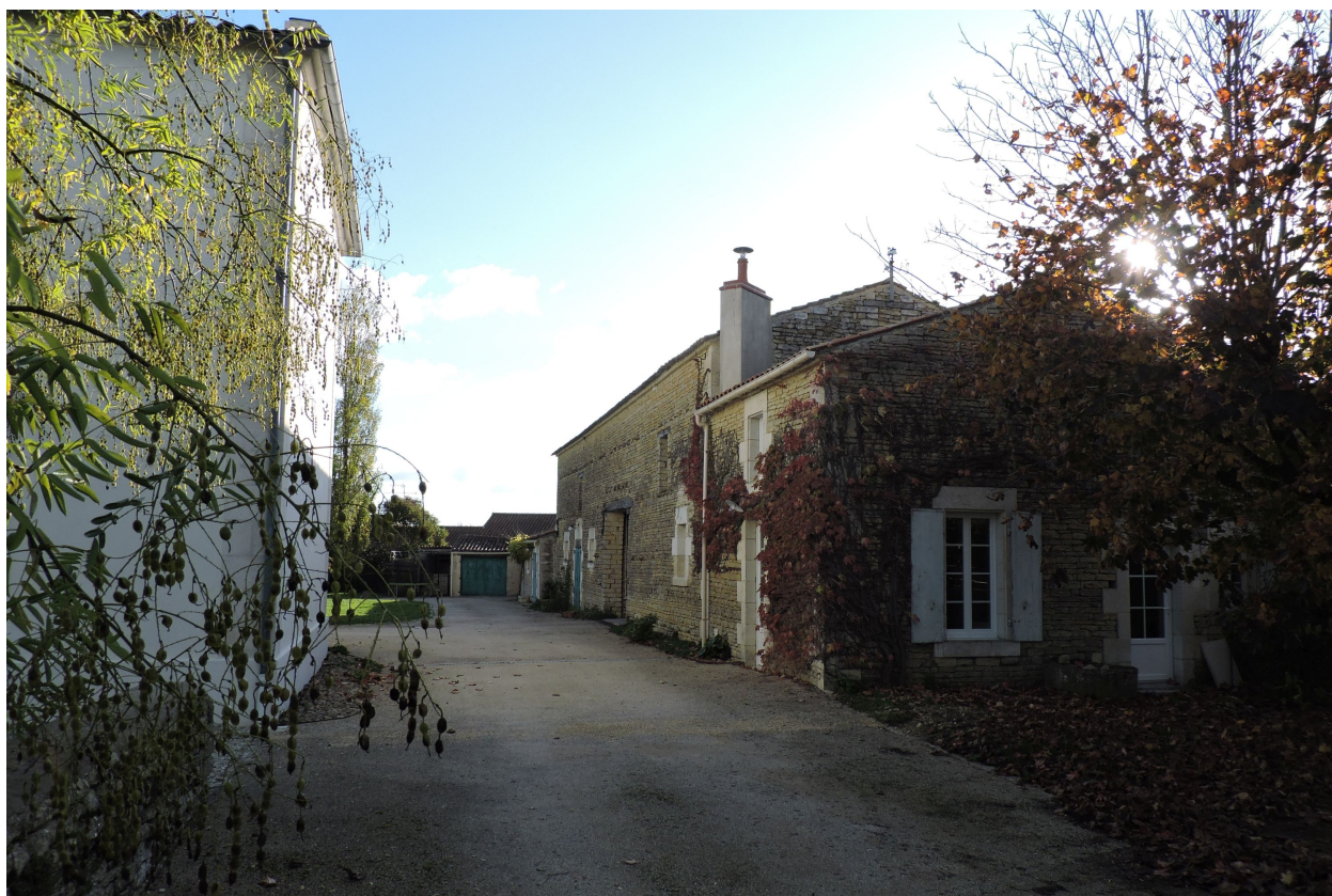
Les dépendances vues depuis le nord-est.
