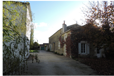
Les dépendances vues depuis le nord-est. Phot. Yannis Suire IVR52_20218500604NUCA
