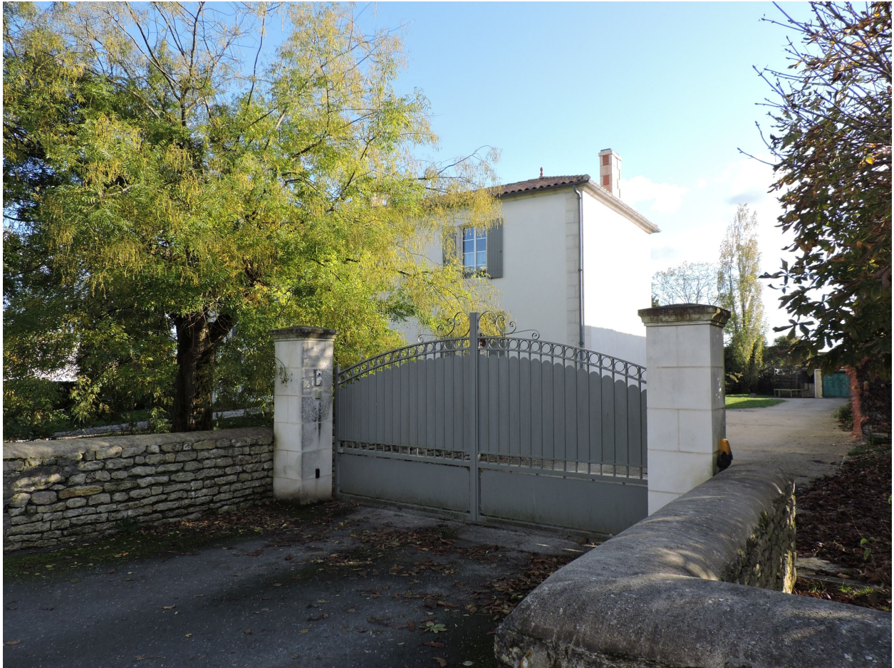
Le logis vu depuis le nord-ouest.
