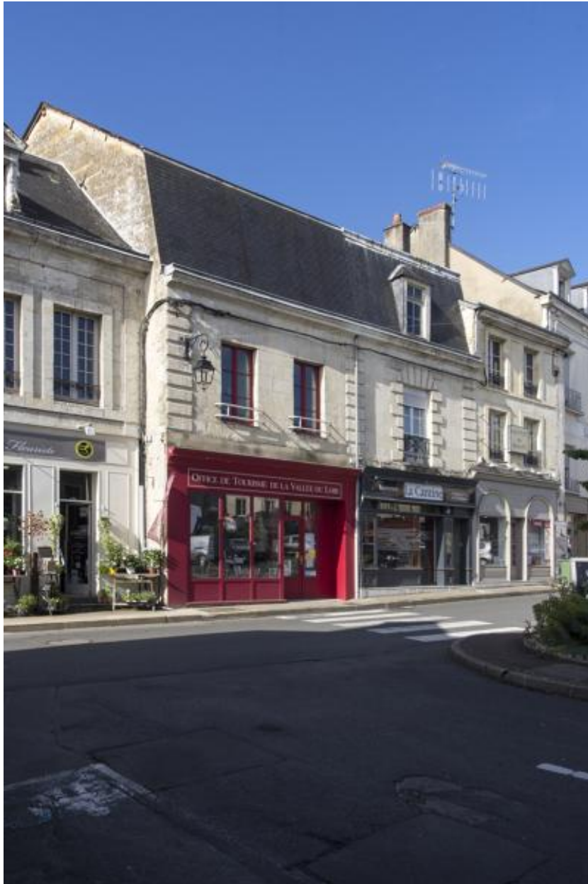
La Chartre-sur-le-Loir, place de la République : maisons côté sud.
