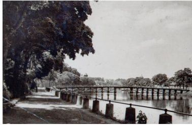
La passerelle de la cale : vue d'ensemble depuis la rive droite. Phot. Gilbert IVR52_20235300091NUCA
