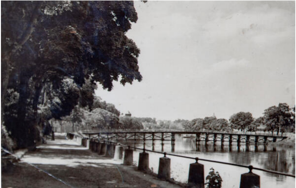
La passerelle de la cale : vue d'ensemble depuis la rive droite.
