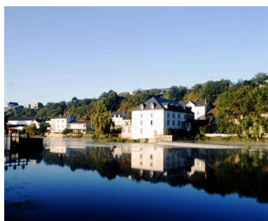
Vue d'ensemble du site du moulin, depuis la rive gauche, en amont. Phot. François Lasa IVR52_19885300706XA
