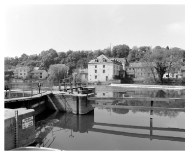
Vue d'ensemble de l'écluse, du barrage et du moulin depuis la rive gauche. Phot. François Lasa IVR52_20025300621X
