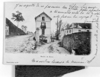
Vue du moulin depuis la rue du Vieux-Saint-Louis : cour du moulin et maison du meunier. Autr. Désiré et Henriette Hamel-Jallier, Repro. François Lasa IVR52_20015300367X
