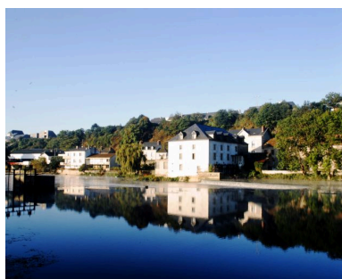
Vue d'ensemble du site du moulin, depuis la rive gauche, en amont. Phot. François Lasa IVR52_19885300706XA
