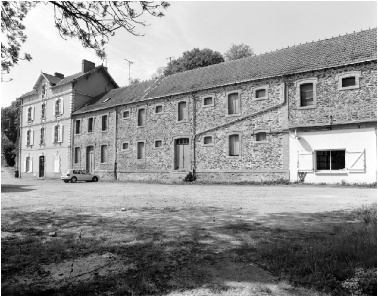
Maison du meunier et dépendances, vue d'ensemble depuis le nord-est.
