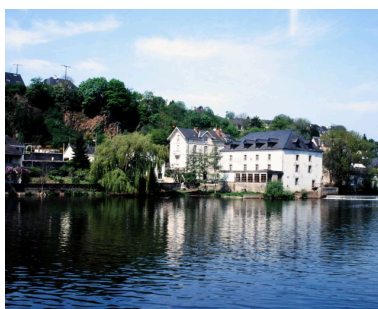
Vue d'ensemble du moulin, depuis la rive gauche, en aval. Phot. François Lasa IVR52_20025300619XA
