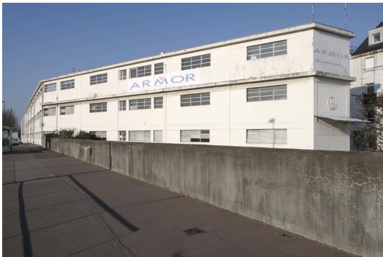
Atelier de fabrication 1, côté rue.
