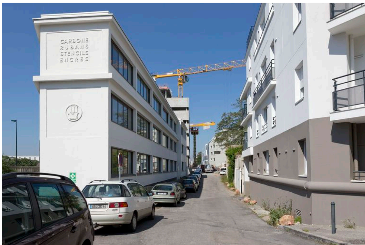
Pointe d'Armor réhabilitée, 2013.
