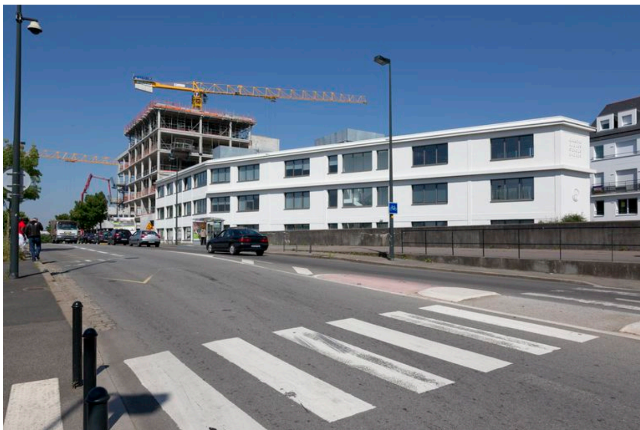
Pointe d'Armor réhabilitée, 2013.
