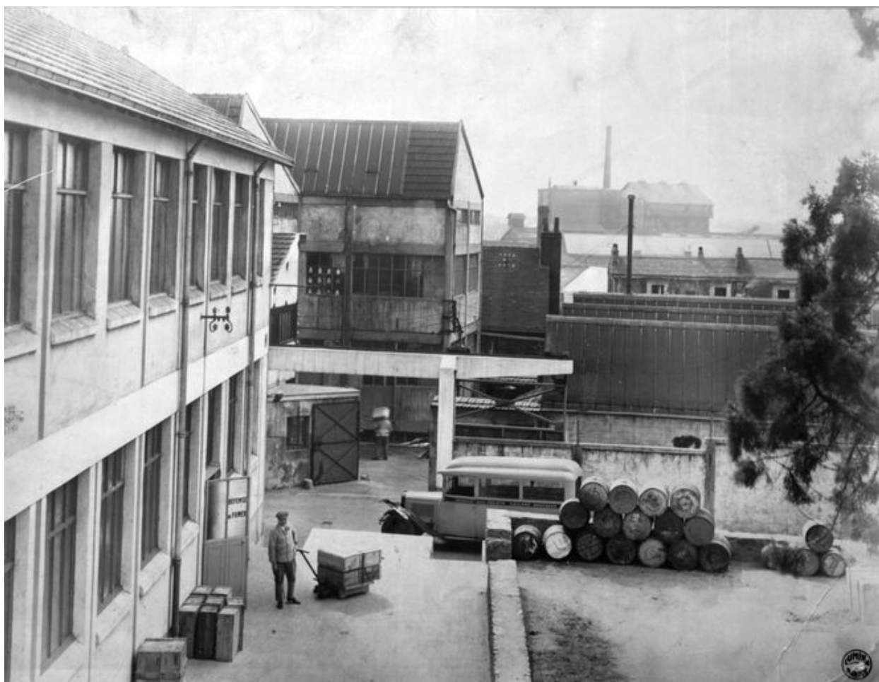
Vue de la cour de l'usine Armor vers la Savonnerie de la Loire.
