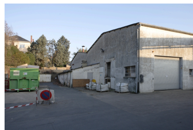
Atelier de fabrication d'encre 3. Phot. Denis Pillet IVR52_20094401508NUCA
