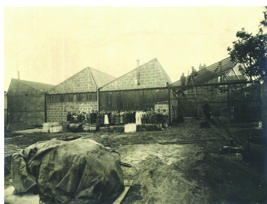
Premiers bâtiments de l'usine détruits dans les années 1940. Phot. Denis (reproduction) Pillet IVR52_20104400821NUCA
