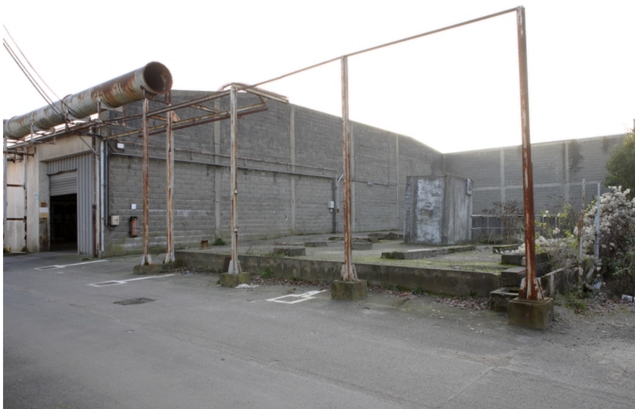
Stockage des carburants et des solvants.
