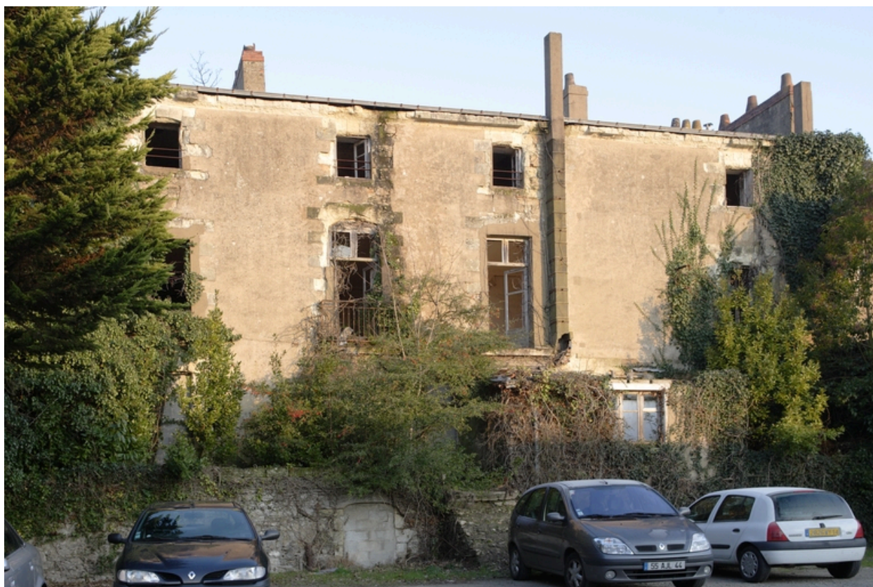
Logement pour le personnel (?).
