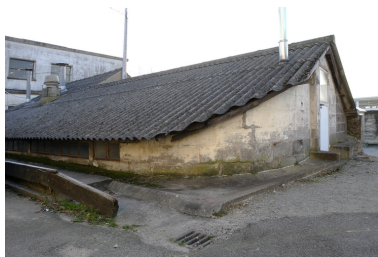
Atelier de réparation 2, construit avant 1947. Phot. Denis Pillet IVR52_20094401502NUCA
