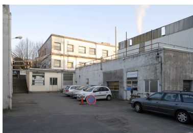
Axe sud-nord, vers l'ancien laboratoire, arrière de la chaufferie. Phot. Denis Pillet IVR52_20094401496NUCA
