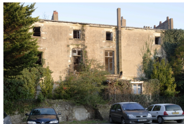
Logement pour le personnel (?). Phot. Denis Pillet IVR52_20094401490NUCA
