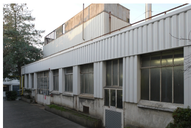
Chaudière, construite en 1945 Phot. Denis Pillet IVR52_20094401481NUCA
