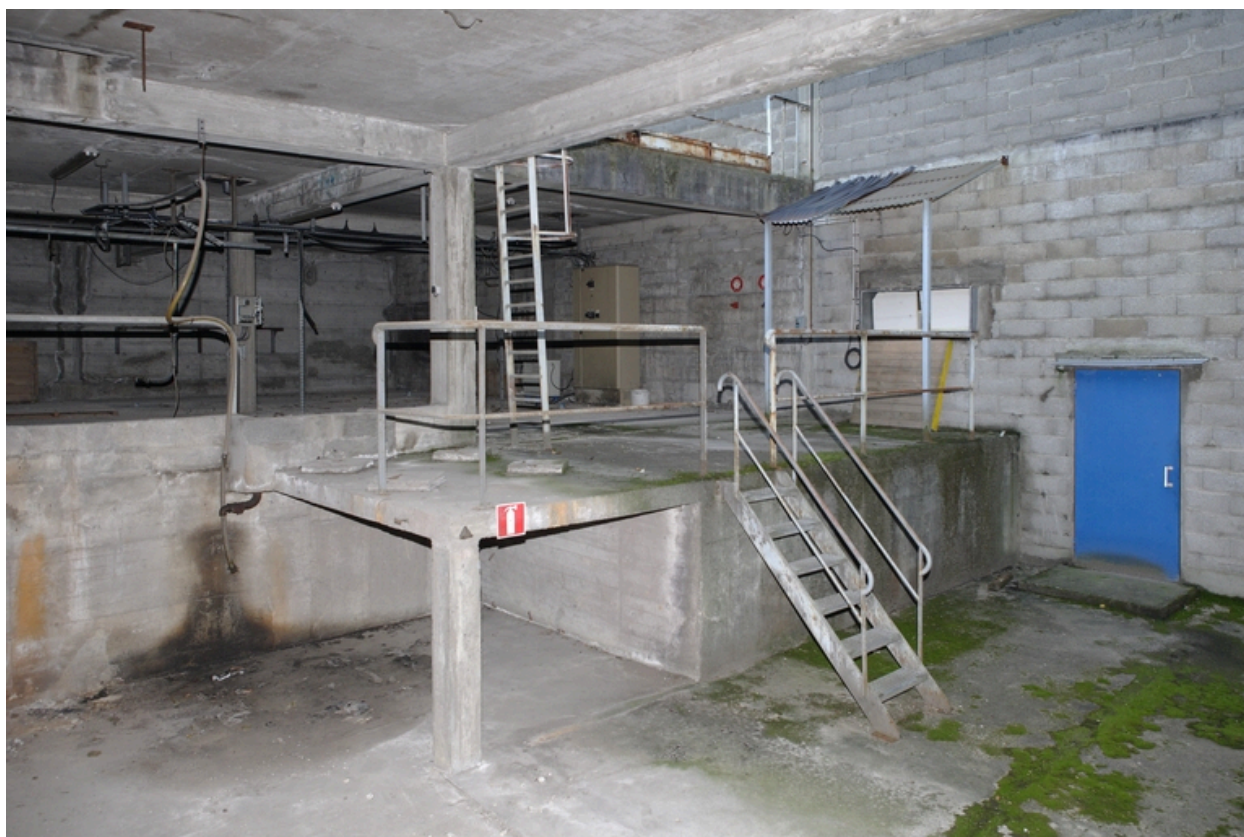
Stockage des carburants et des solvants.
