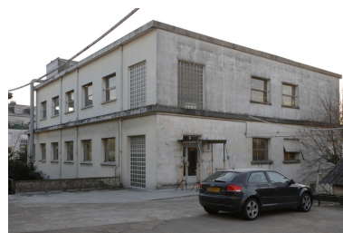
Bâtiment administratif, construit en 1948. Phot. Denis Pillet IVR52_20094401489NUCA
