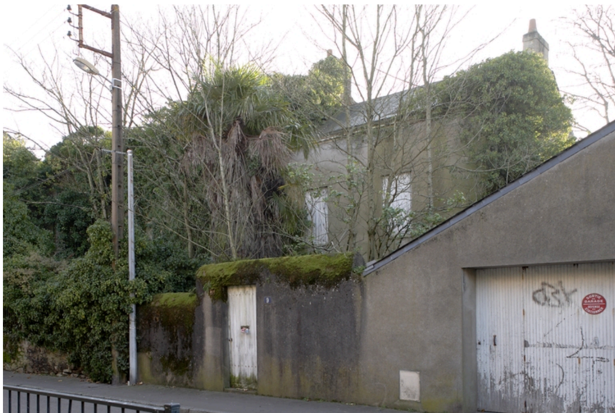
Logement pour le personnel (?), rue des Réformes.
