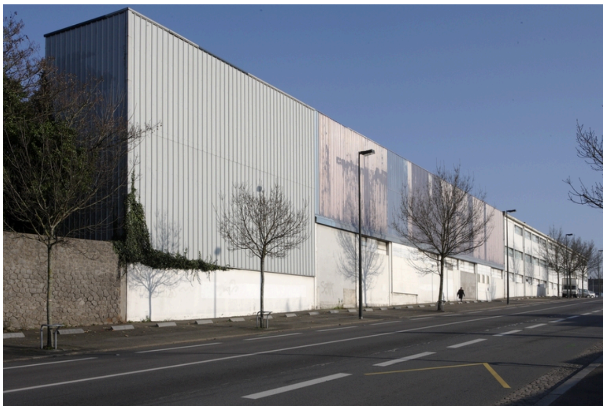
Atelier de fabrication 1, côté rue.
