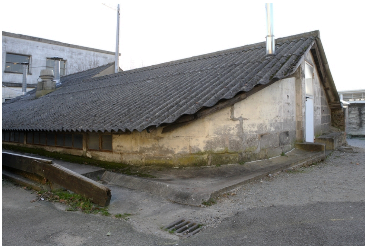
Atelier de réparation 2, construit avant 1947.
