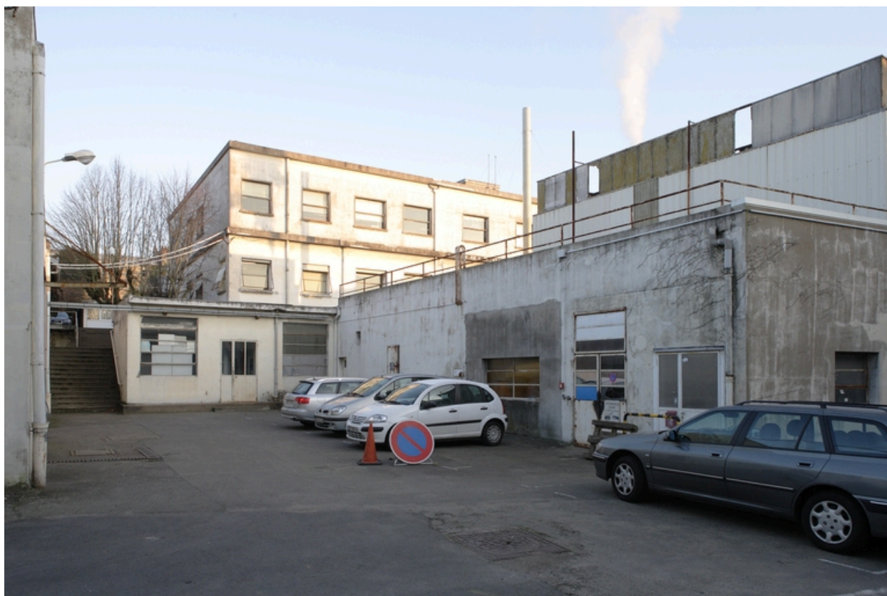
Axe sud-nord, vers l'ancien laboratoire, arrière de la chaufferie.
