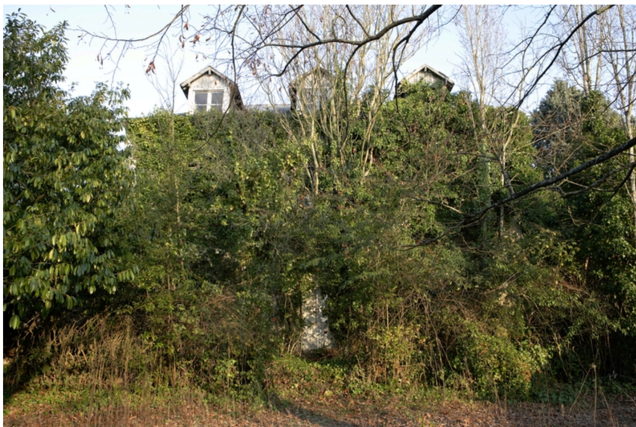
Maison abandonnée sur le site de l'entreprise.
