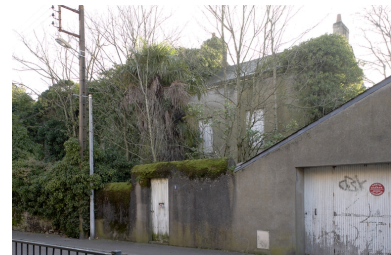
Logement pour le personnel (?), rue des Réformes. Phot. Denis Pillet IVR52_20094401549NUCA
