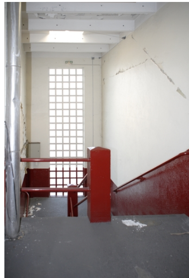
Atelier de fabrication 1, escalier central du bâtiment, palier du 2ème étage. Phot. Denis Pillet IVR52_20094401533NUCA
