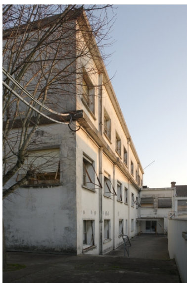
Bâtiment administratif, construit en 1948. Phot. Denis Pillet IVR52_20094401482NUCA
