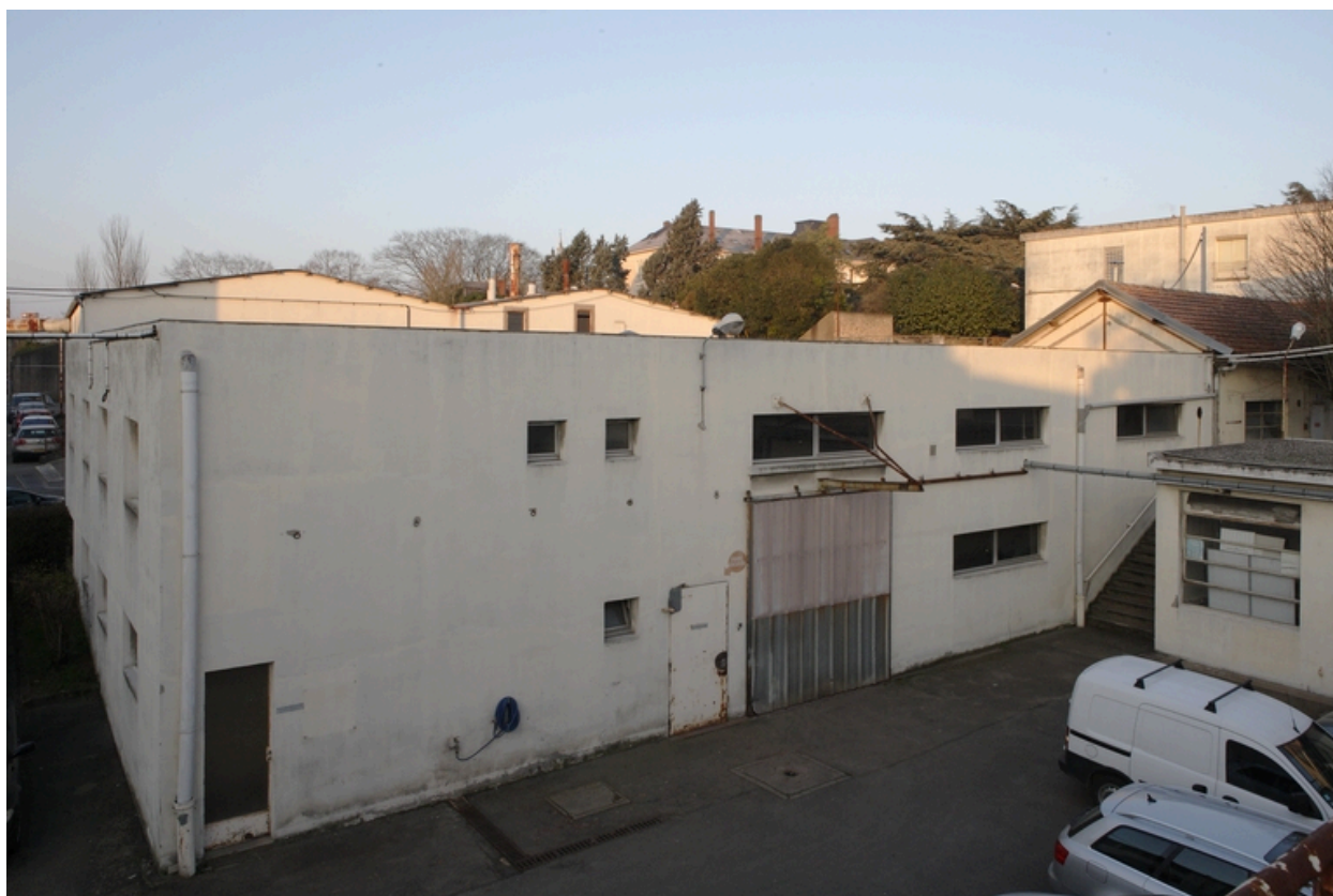
Atelier de réparation 1, construit en 1951.
