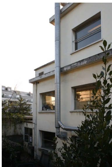
Bâtiment administratif, construit en 1948. Phot. Denis Pillet IVR52_20094401491NUCA
