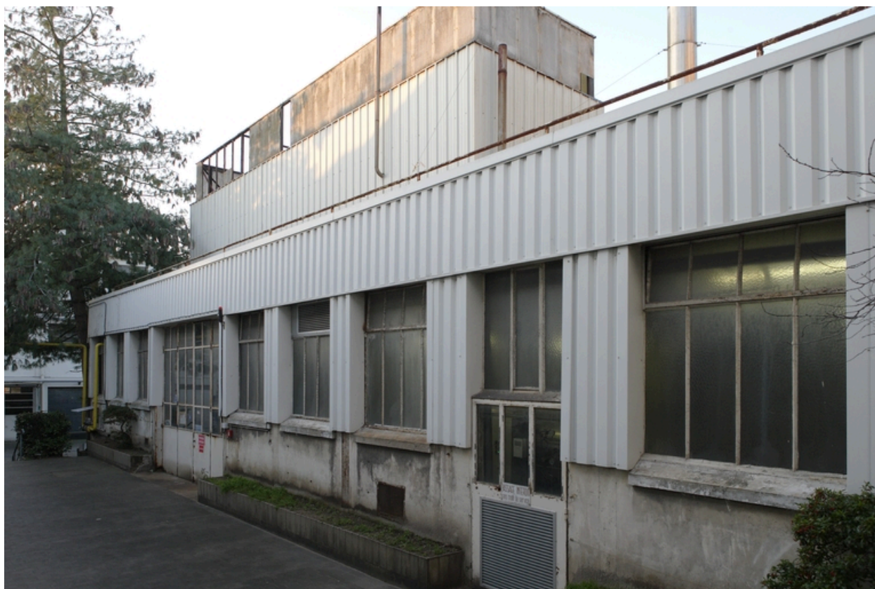
Chaufferie, construite en 1945
