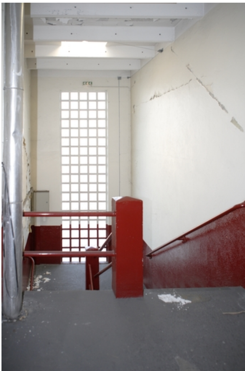
Atelier de fabrication 1, escalier central du bâtiment, palier du 2ème étage.
