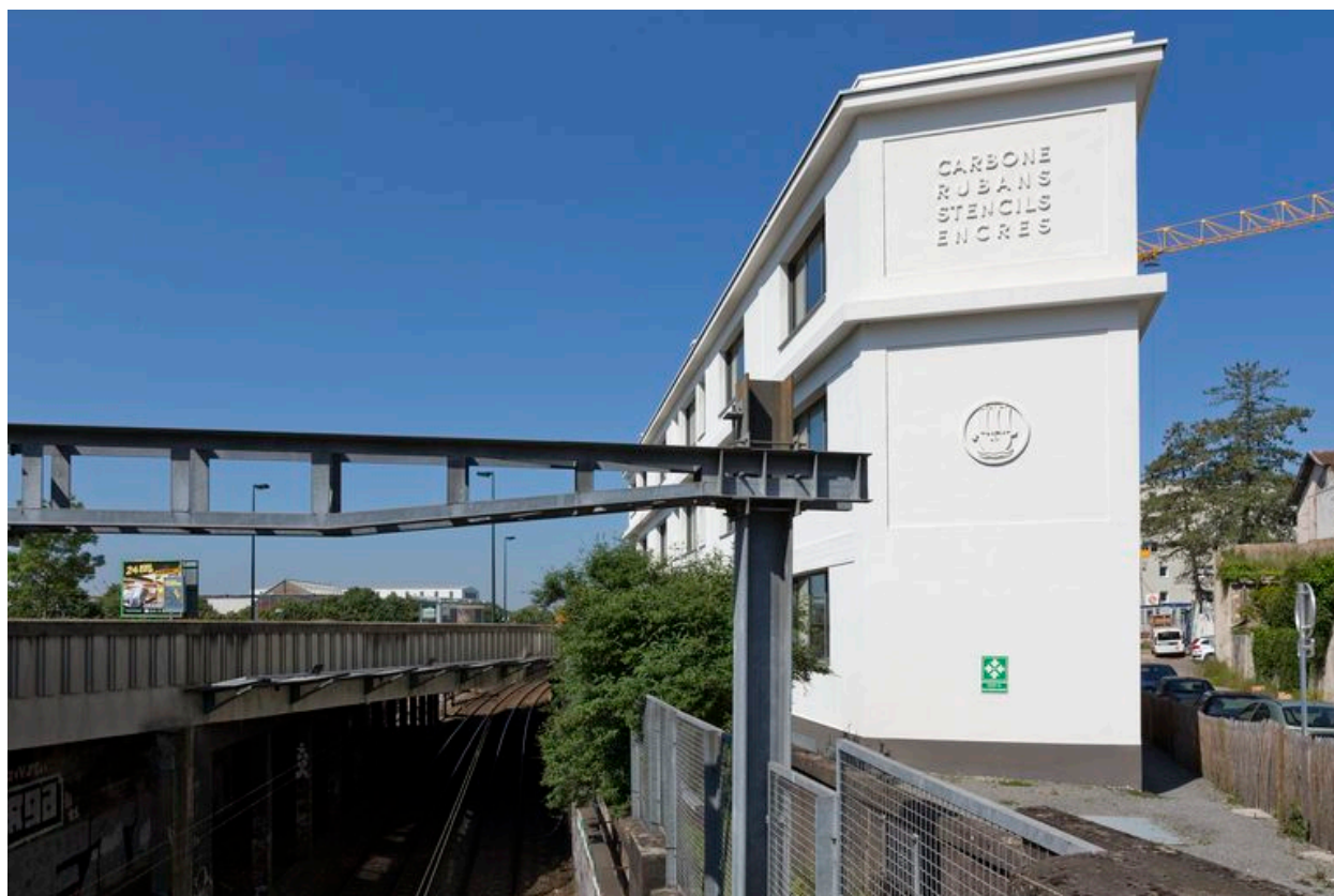
Pointe d'Armor réhabilitée, 2013.
