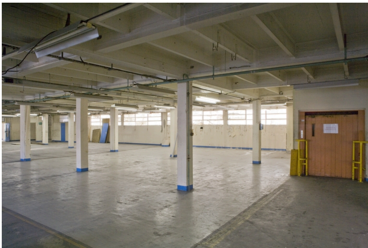
Atelier de fabrication 1, 1er étage.
