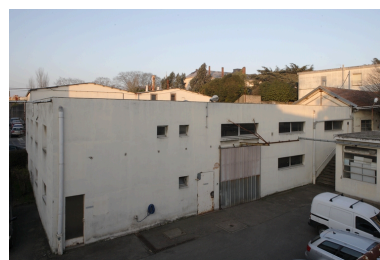
Atelier de réparation 1, construit en 1951. Phot. Denis Pillet IVR52_20094401486NUCA
