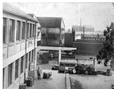
Vue de la cour de l'usine Armor vers la Savonnerie de la Loire. IVR52_20134400940NUCA
