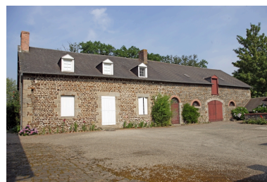
Le bâtiment abritant le logis, la cave et sans doute une étable. Phot. François Lasa IVR52_20065300706NUCA
