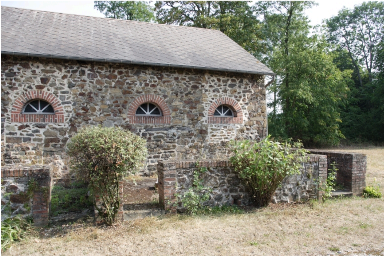
L'ancienne porcherie et son enclos vus depuis le chemin au sud.
