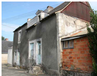
Rue du Gratte-Poule : maison. Phot. Jean-Baptiste Darrasse IVR52_20067206807NUCA
