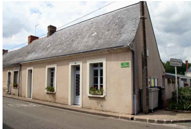
Rue des Pensées, autre logement réhabilité. Phot. Jean-Baptiste Darrasse IVR52_20067206860NUCA
