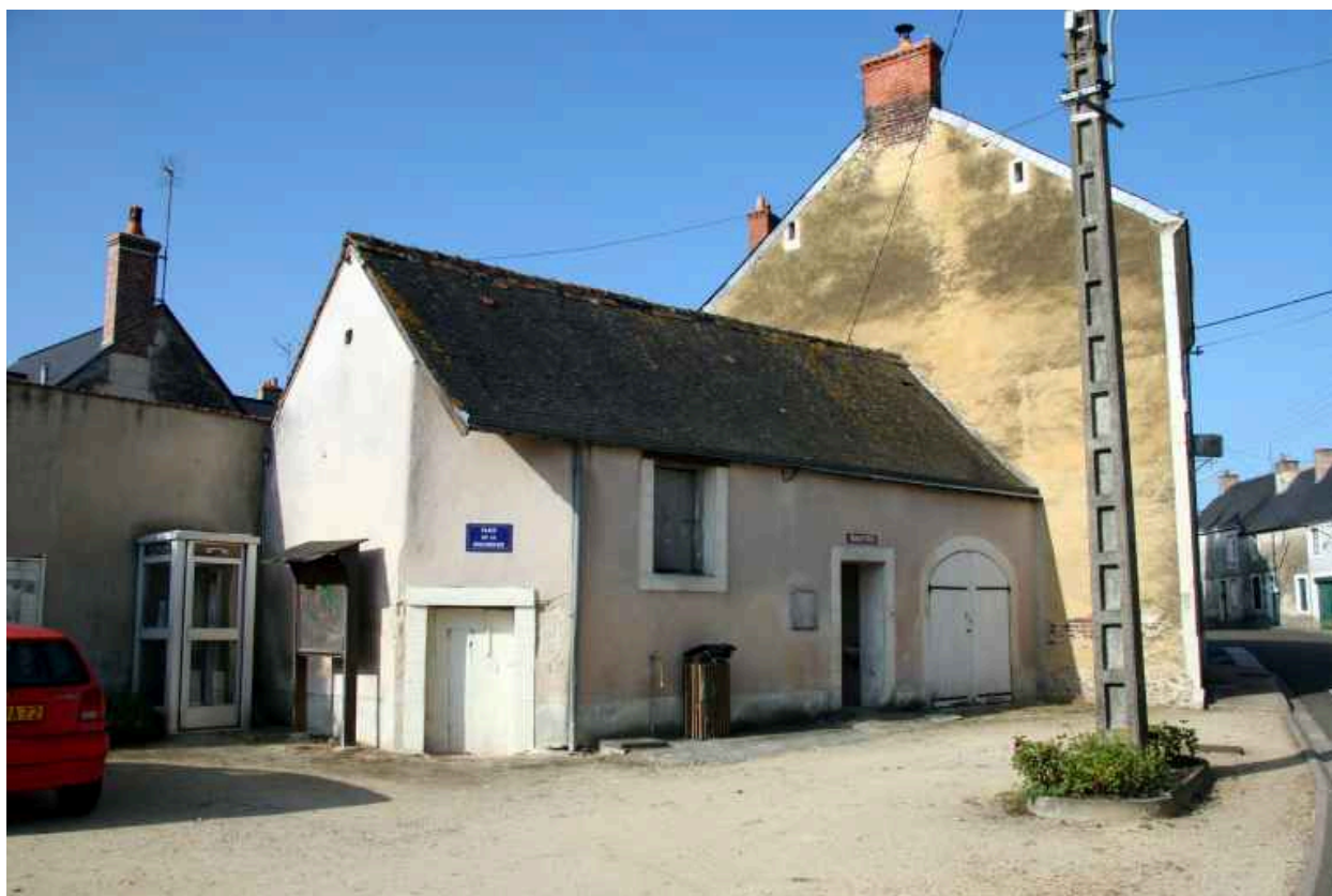
Rue des Mimosas : vestiges de l'ancienne boulangerie.
