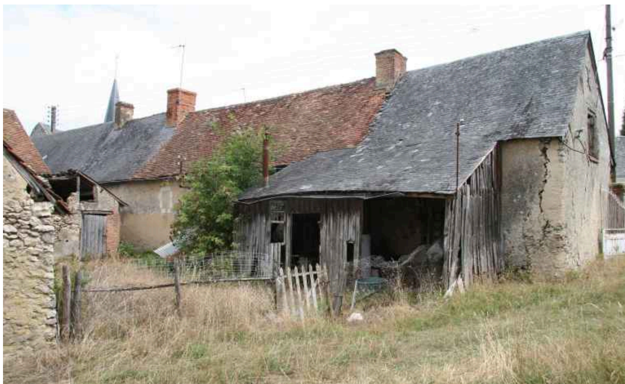
Rue des Pensées, rive ouest, façade postérieure des logements en série sur potagers : aucune ouverture.
