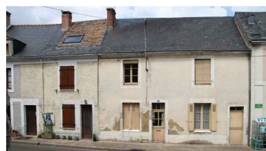
Îlot 1, place de l'Europe : quatrième grande maison à étage.
