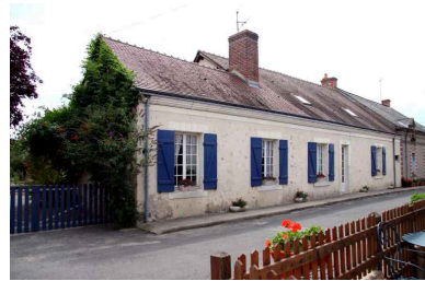
Rue Altéa (anciennement du Haut-Bourg) : rive sud. Phot. Jean-Baptiste Darrasse IVR52_20067206885NUCA
