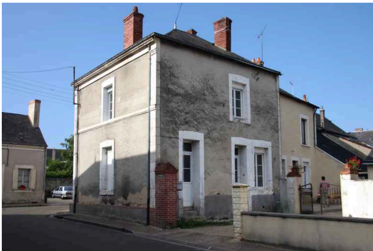
Rue des Mimosas, maison d'angle : façade postérieure.
