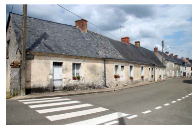
Entrée sud du bourg, rue des Pensées : logements en série. Phot. Jean-Baptiste Darrasse IVR52_20067206864NUCA
