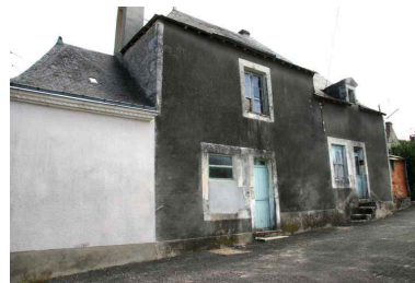
Rue du Gratte-Poule. Phot. Jean-Baptiste Darrasse IVR52_20067206806NUCA
