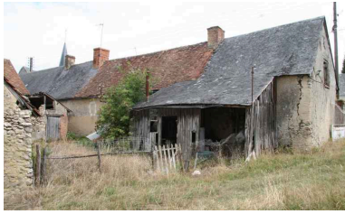
Rue des Pensées, rive ouest, façade postérieure des logements en série sur potagers : aucune ouverture. Phot. Jean-Baptiste Darrasse IVR52_20067206866NUCA
