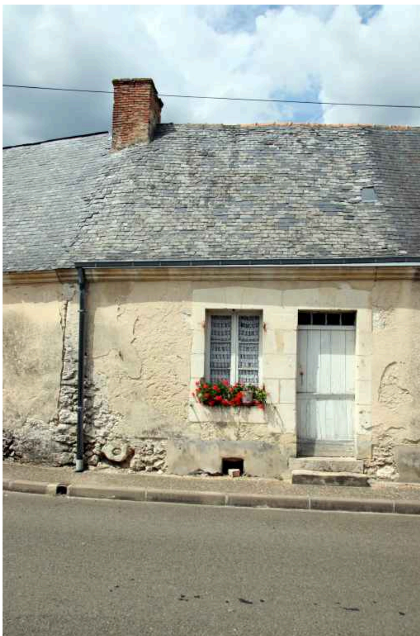
Rue des Pensées, rive ouest : autre logement.
