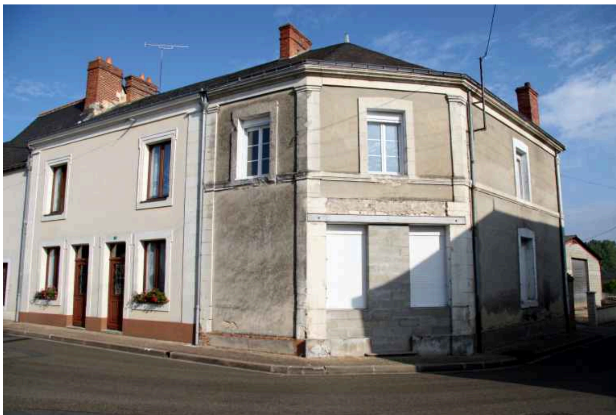
Îlot 2, rue des Mimosas : maison d'angle.
