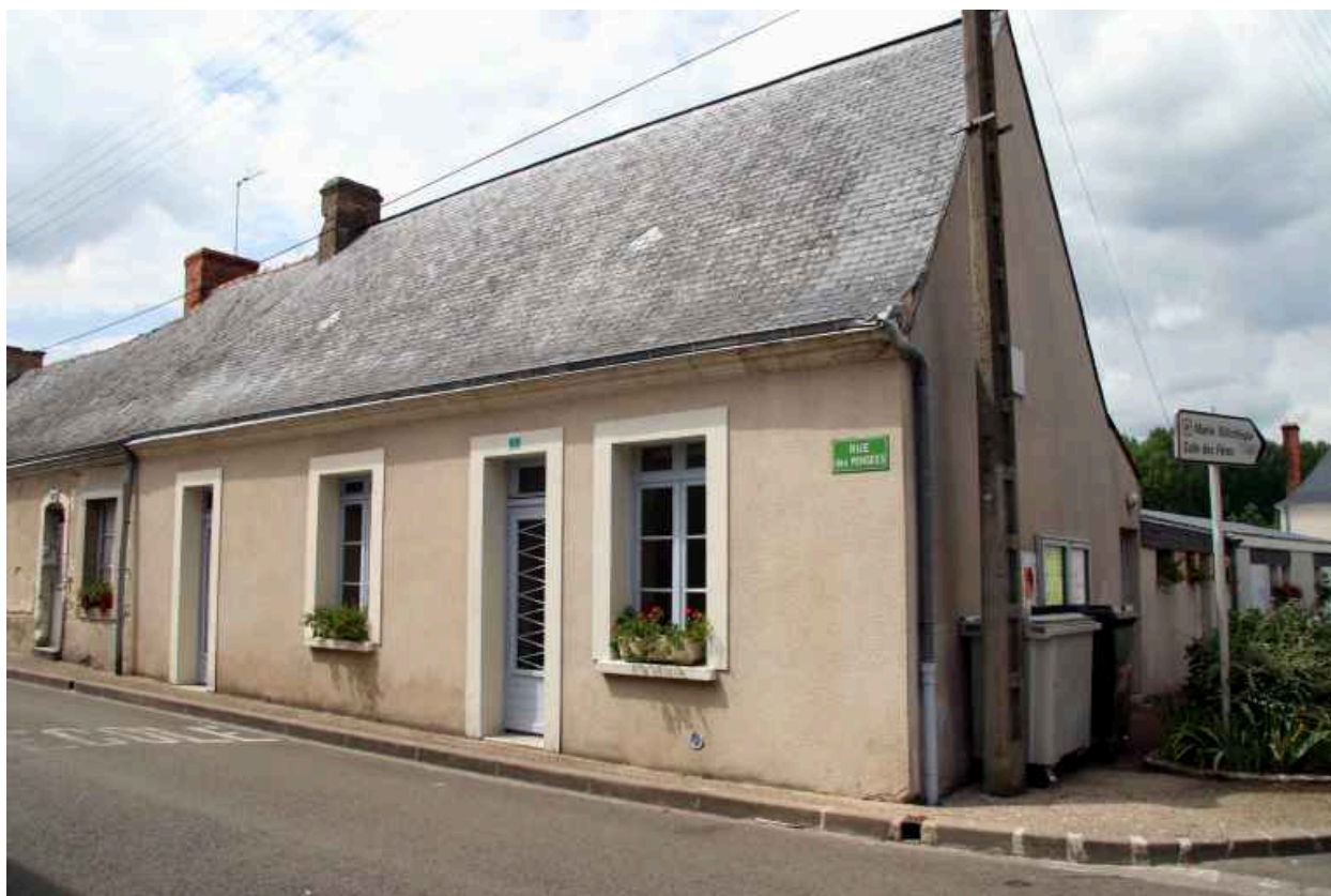
Rue des Pensées, autre logement réhabilité.
