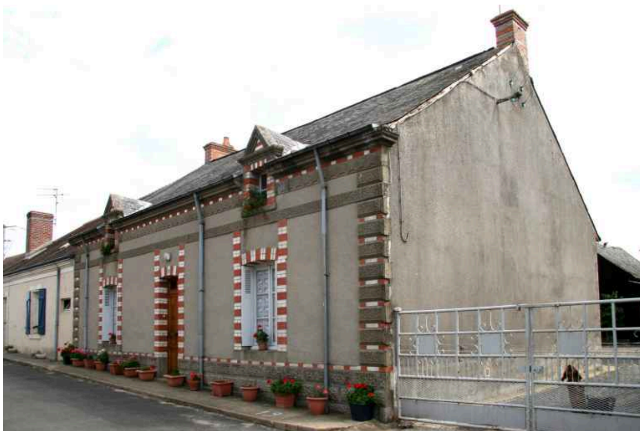
Rue Altéa, rive sud : maison semblable à celle du hameau du Puits.
