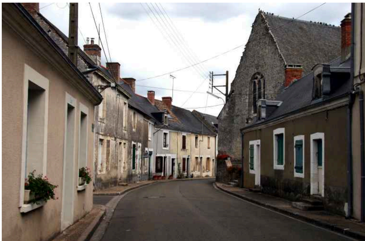
La route d'Orléans à Baugé, ilot 1 : maisons sur l'ancienne place de l'église, actuellement place de l'Europe.
