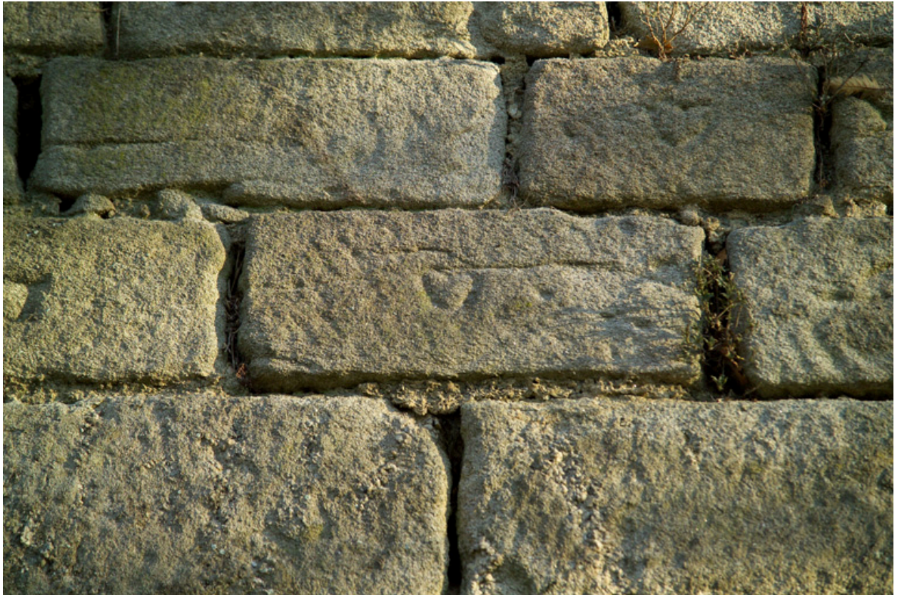
Marques lapidaires sur l'enceinte urbaine.
