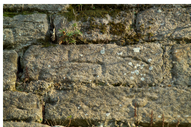
Marques lapidaires sur l'enceinte urbaine. Phot. Denis Pillet IVR52_20054402209NUCA
