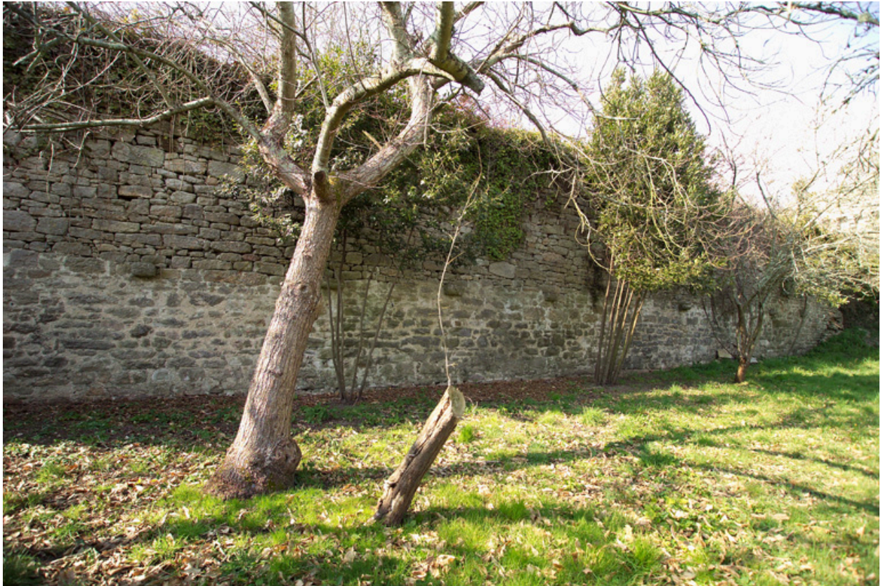
Vue depuis l'intramuros du parement de l'enceinte urbaine entre la tour de la Gaudnais et la tour de l'Abreuvoir.
