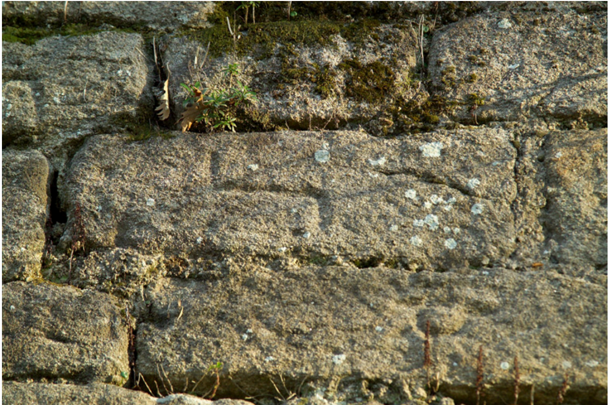
Marques lapidaires sur l'enceinte urbaine.
