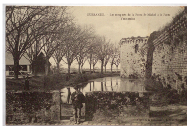
Les remparts de la porte Saint-Michel à la porte Vannetaise. Carte postale. 1er quart XXe siècle. Phot. Denis (reproduction) Pillet IVR52_20074400877NUCA
