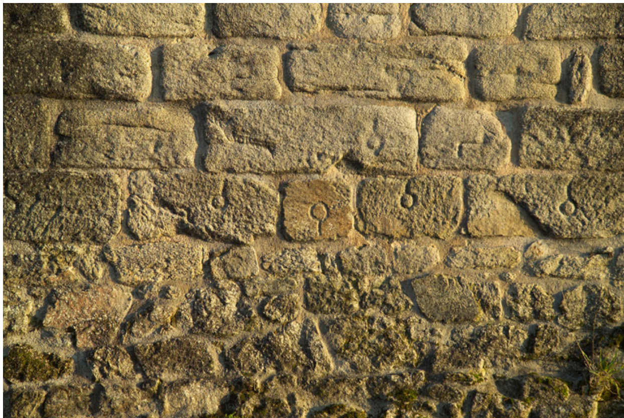
Marques lapidaire sur l'enceinte urbaine.
