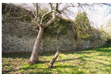
Vue depuis l'intramuros du parement de l'enceinte urbaine entre la tour de la Gaudnais et la tour de l'Abreuvoir. Phot. Denis Pillet IVR52_20064402110NUCA
