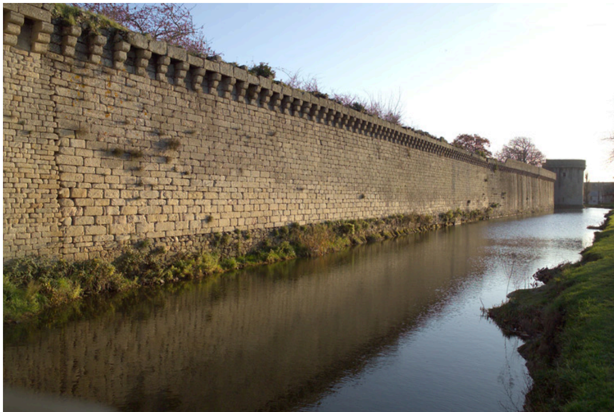
Enceinte urbaine et tour de l'Abreuvoir.
