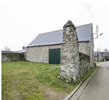
Ancienne grange aux dîmes. Phot. Yves Guillotin IVR52_20225300051NUCA
