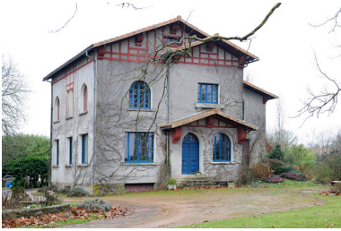
Villa de Bernard Pasquier, située au 7 rue d'Anjou, construite à la fin des années 1930. Phot. Bruno Rousseau IVR52_20114900279NUCA
