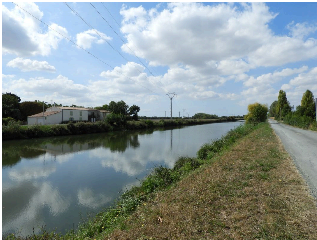
La Victorine au bord du canal de Pomère, vue depuis le nord-est.
