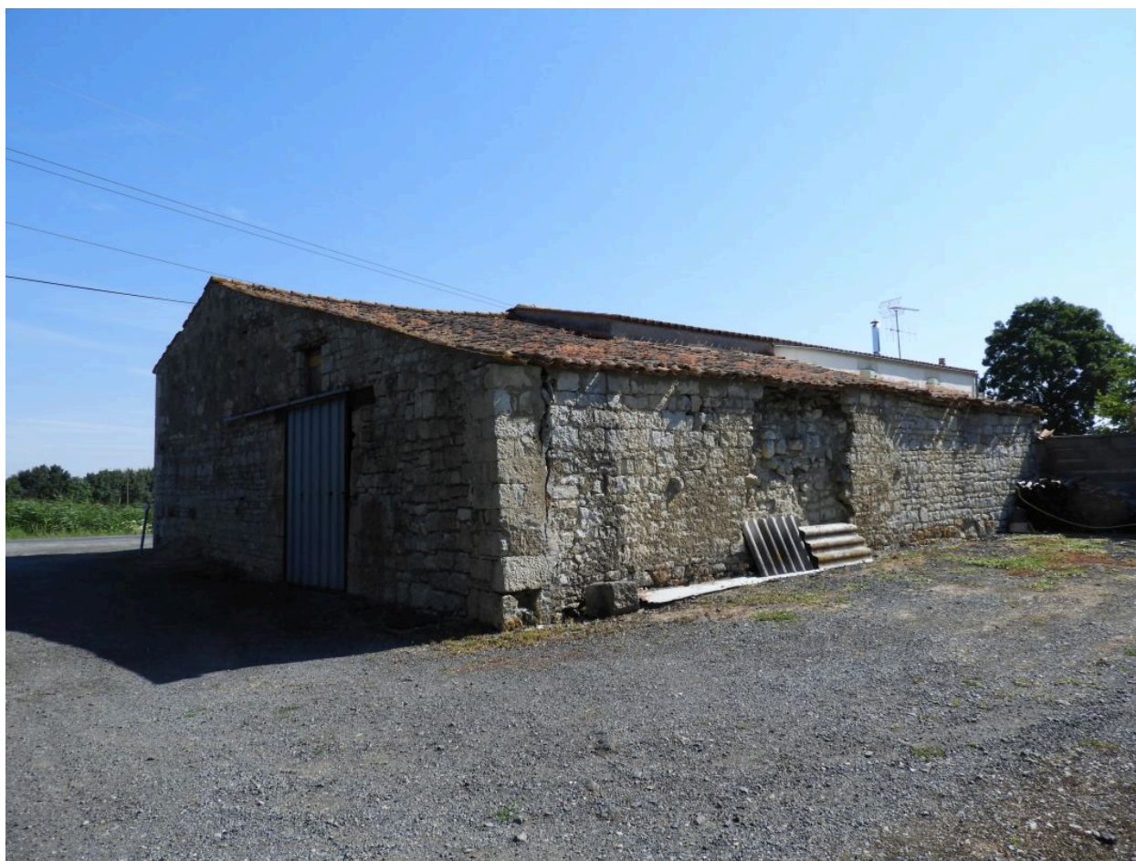
La grange-étable vue depuis le sud-ouest.
