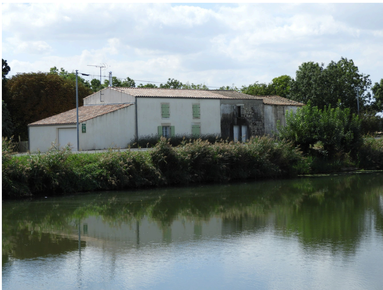
La Victorine vue depuis le nord-est.
