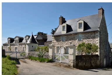
12 chemin des Prises. Maison. 17e siècle. Phot. Bruno Rousseau IVR52_20144900452NUCA
