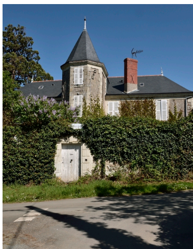
2 route de Mantelon. Maison dite du Prieuré. Phot. Bruno Rousseau IVR52_20144900457NUCA
