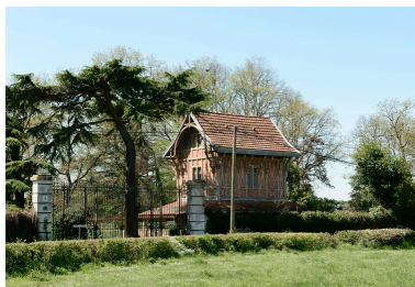
Vue du pavillon d'entrée du château de Mantelon. Phot. Bruno Rousseau IVR52_20144900420NUCA
