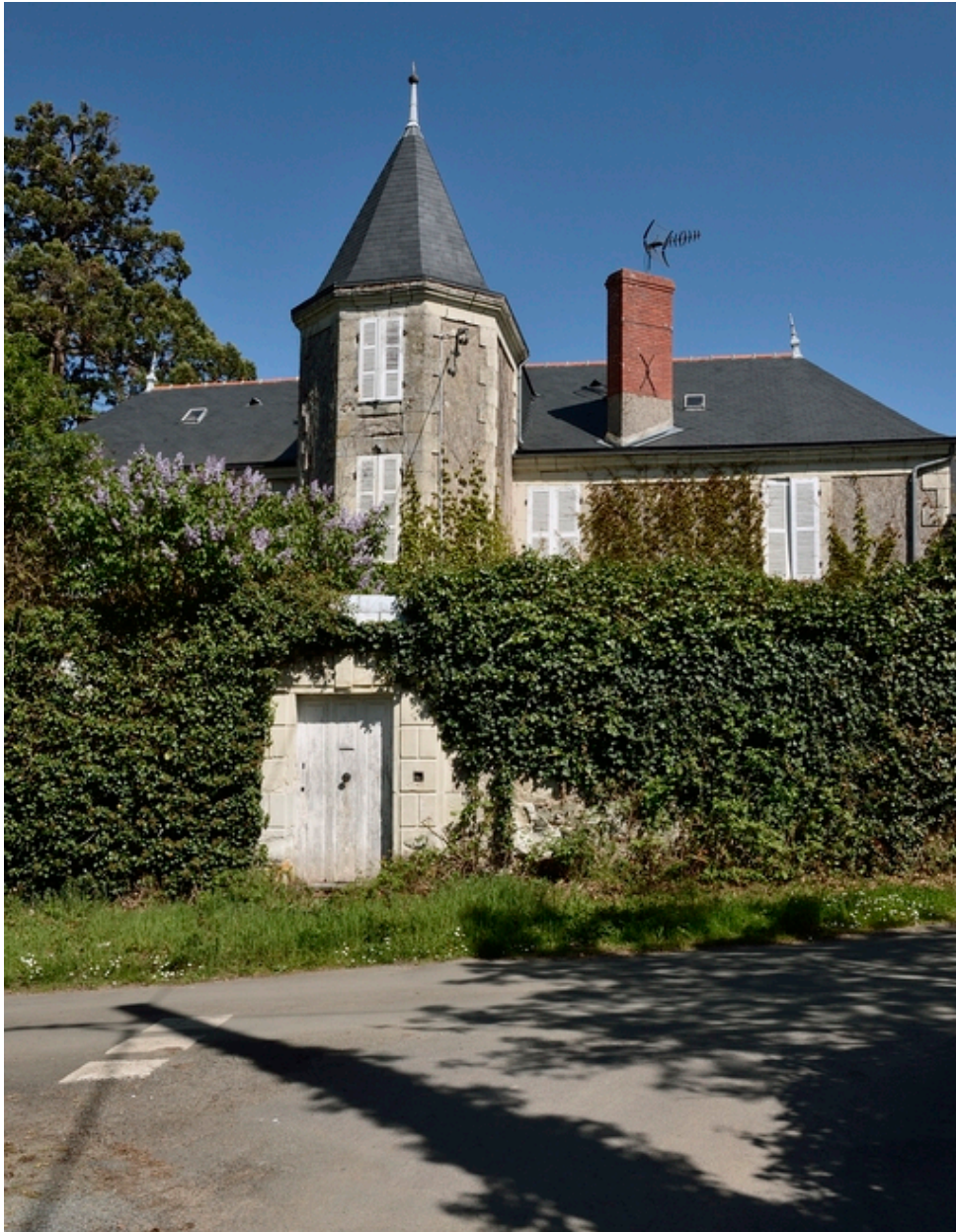
2 route de Mantelon. Maison dite du Prieuré.
