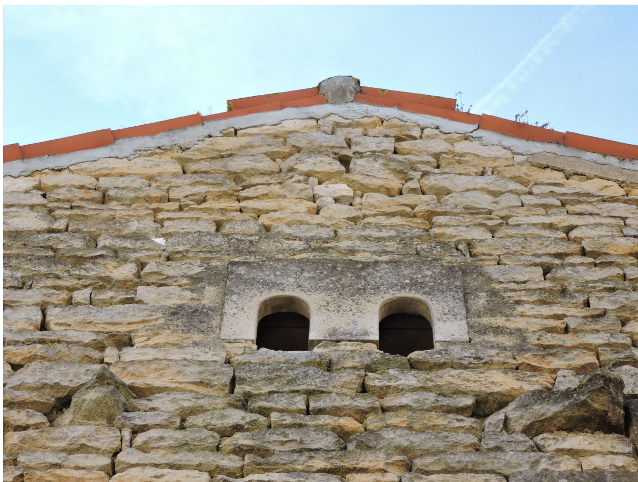
Les boulins à pigeons au sommet de la façade de la remise.
