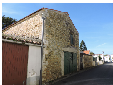
La remise en face de la maison, vue depuis le nord-est.
