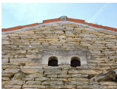
Les boulins à pigeons au sommet de la façade de la remise.
